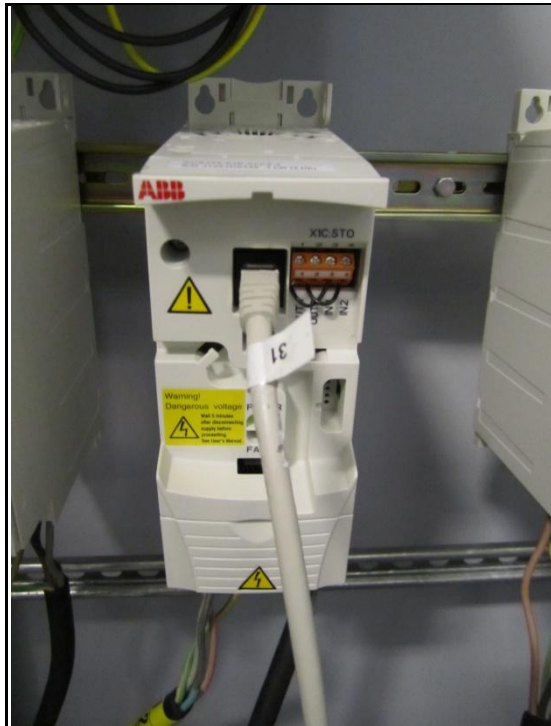
Kuva 27. RJ45-kaapelointi
