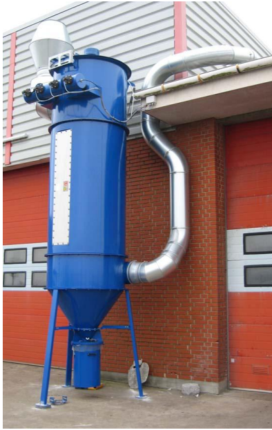
Kuva 25. Puhallussuodatin /4/
