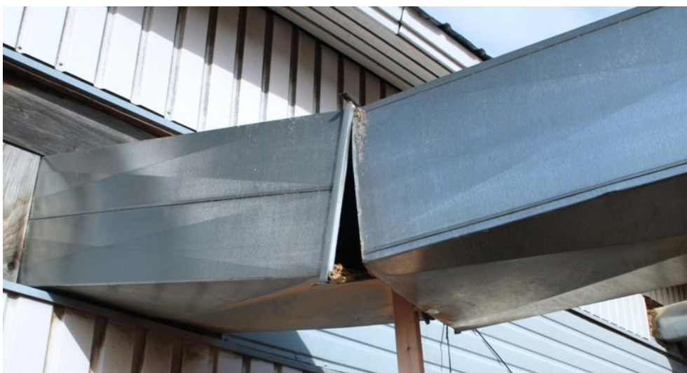
Kuva 15. Lumen rikkoma putki.
