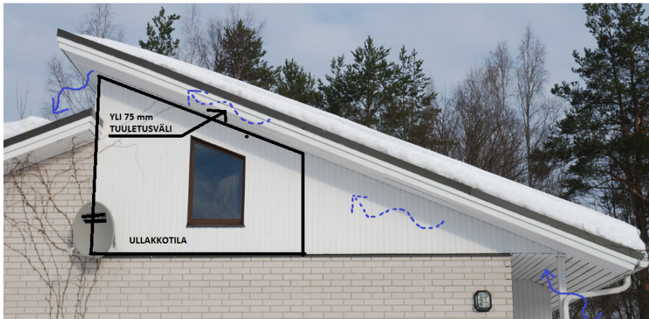
Kuva 7 Pulpettikaton tuuletus
