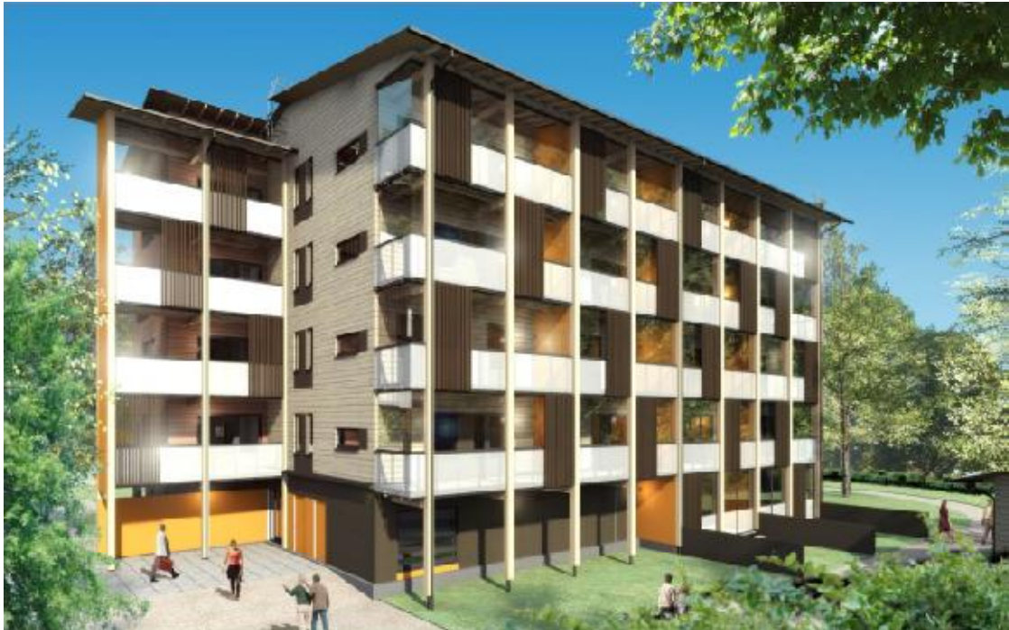
Kuvio 9. Vierumäelle rakenteille oleva puukerrostalo on julkisivultaankin puuta [18.].
