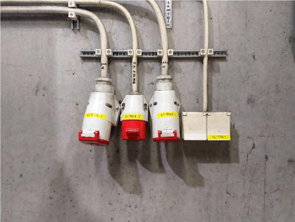
KUVA 20. Pistorasioiden merkinnät
