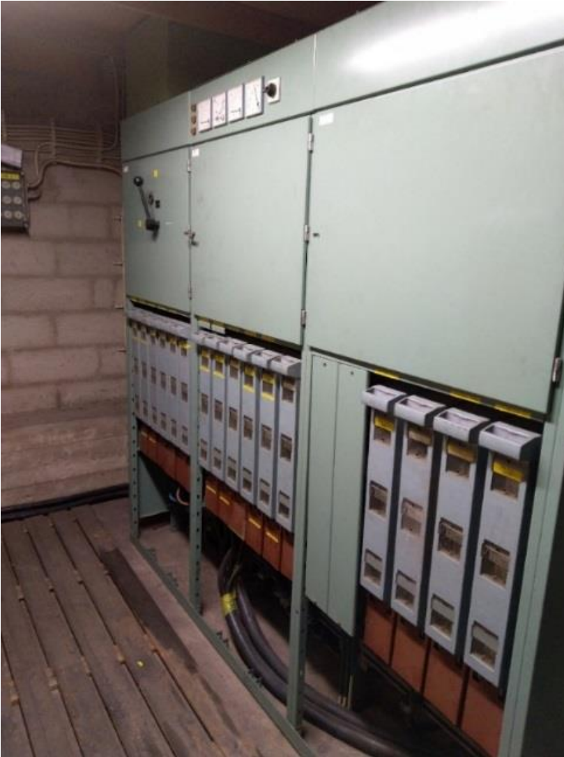
KUVA 5. Vanhin nousukeskus, joka on rakenteeltaan varsin avonainen
