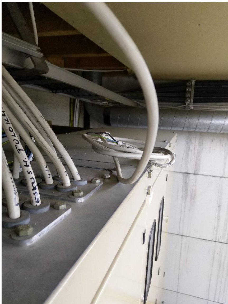
Kuva 15. NK2:sen päältä löytyi jännitteinen kaapeli. Ryhmiä kartoittaessa löysin kaapin päältä irti kytketyn ryhmän, jossa oli 230 V jännite. Onneksi huomasin mitata. KORJATTU 16.10.2018
