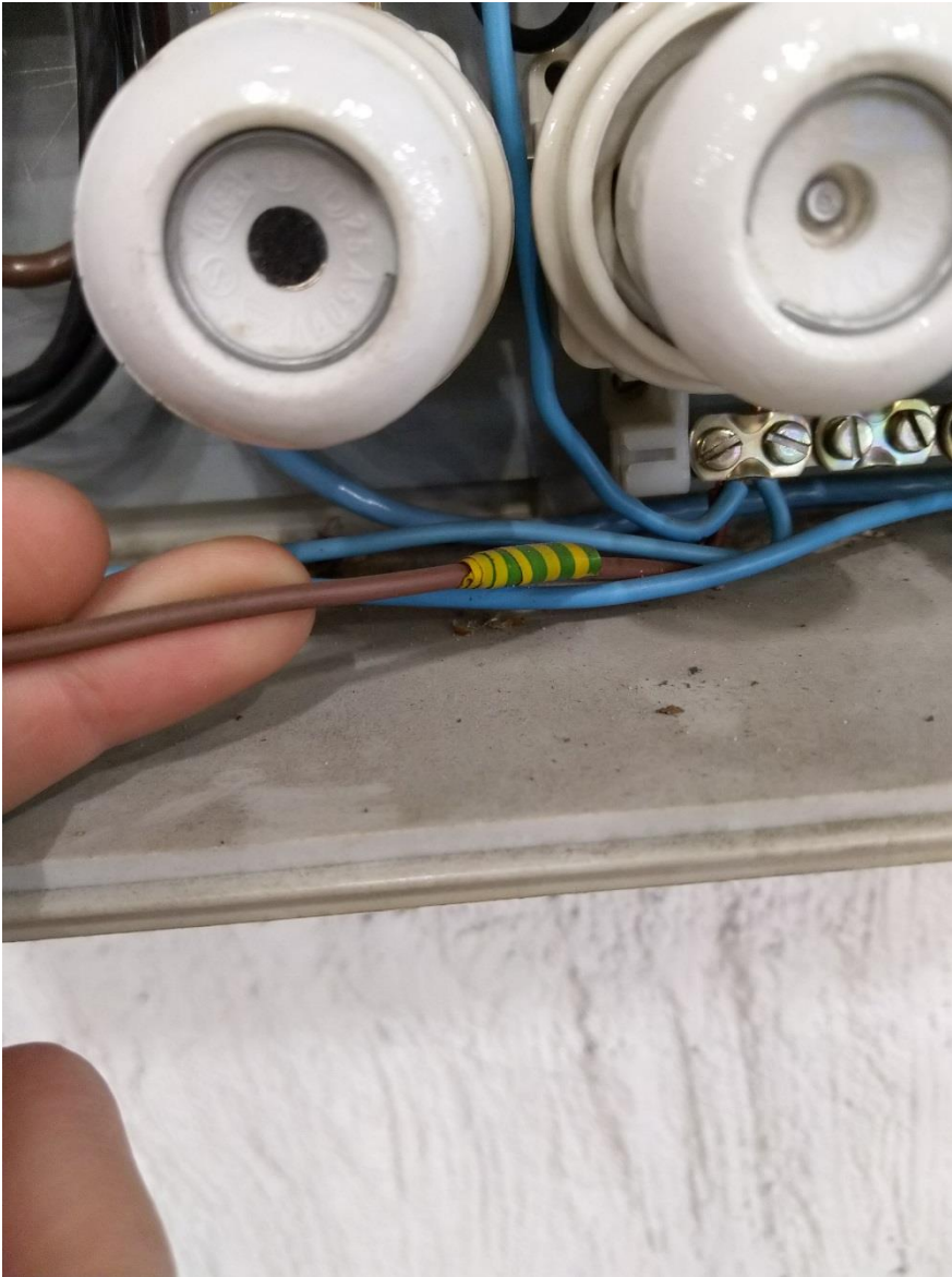
Kuva 9. RK 1.1: ssä ruskeaa johdinta käytetty suojamaadoituksena.
