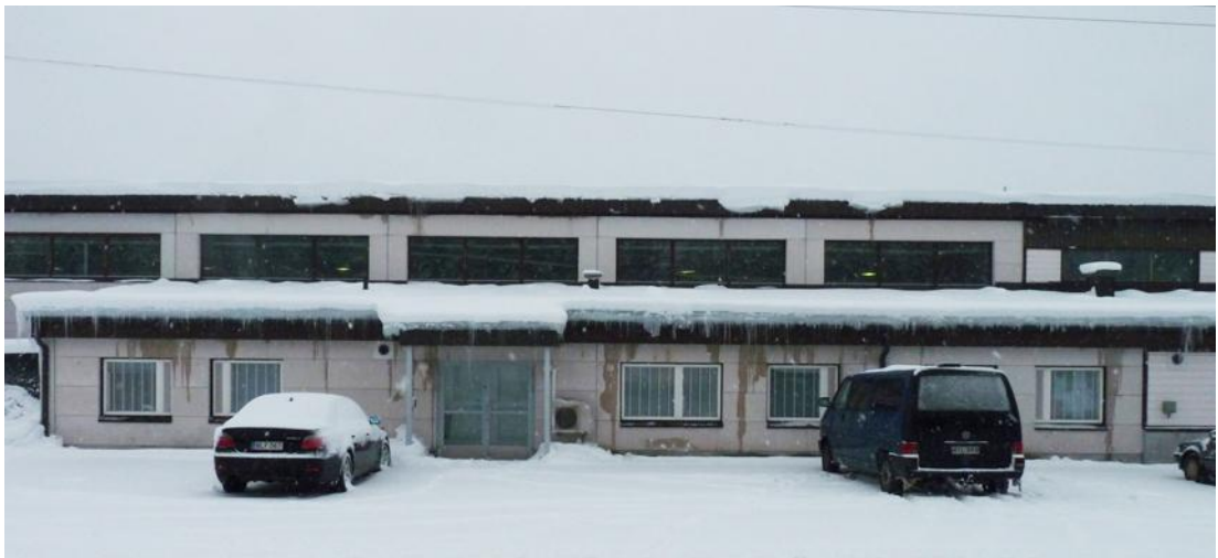
Kuva 4. Yrityksen toimitilojen sisäänkäynti.
