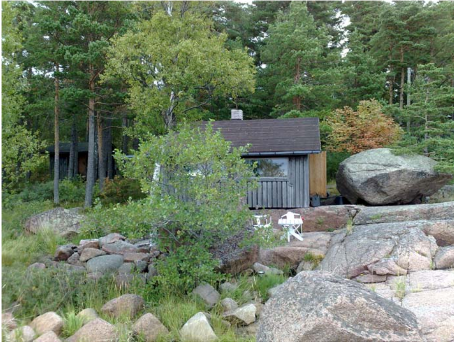
Kuva 2. Rakennuspaikalla sijaitseva mökki
