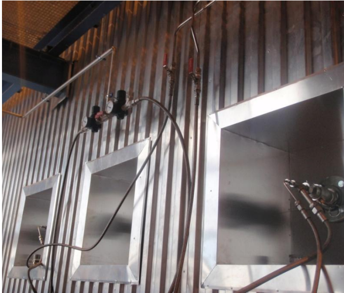
Kuva 22. Uusien suuttimien asennus kattilan vasemmalla puolella. Kuvassa ammoniakkivesilinjat ja hajotusilmalinjat paineenalentimiseen.
