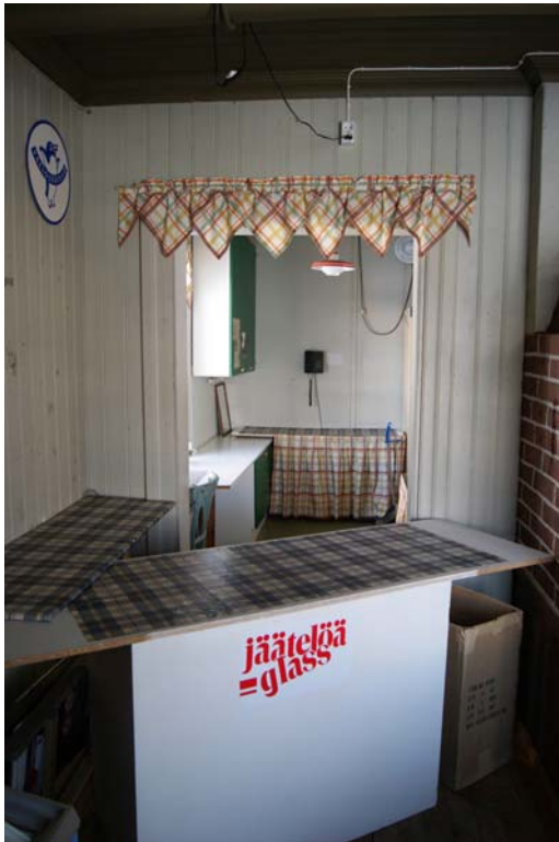
KUVA 38: Kahvilan sisätilyä helmikuussa 2010: helmiponttipaneelit tuvan seinillä, etualalla lastulevyistä kyhätty myyntitiski, taustalla 1970-luvulla tehtyä keittiötä lastulevyseinineen ja vihreine muovimattoineen.
