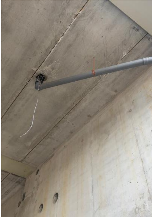
Kuva 9. Vesikatolta vedet voidaan ohjata kaivojen kautta väliaikaisesti muoviputkien avulla.
