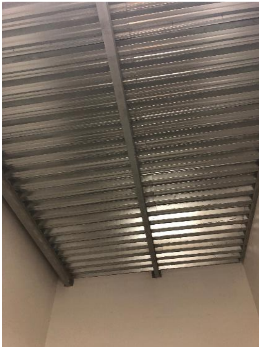
Kuva 12. Tippuvesisuoja teräspoimulevystä ja vesikouru kerääntyvää vettä varten.
