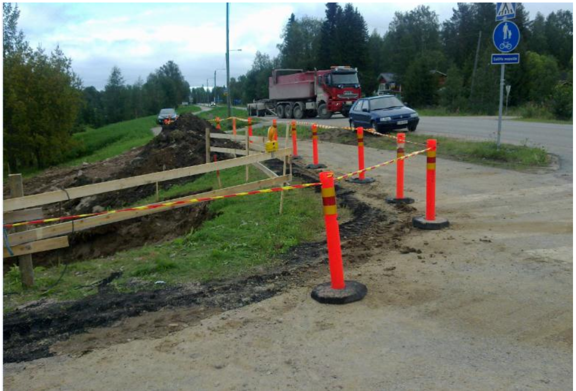
Kuva 7. Näkyvästi suojattu kaivanto kevyenliikenteenväylän reunassa (Kuva: Henri Annala).
