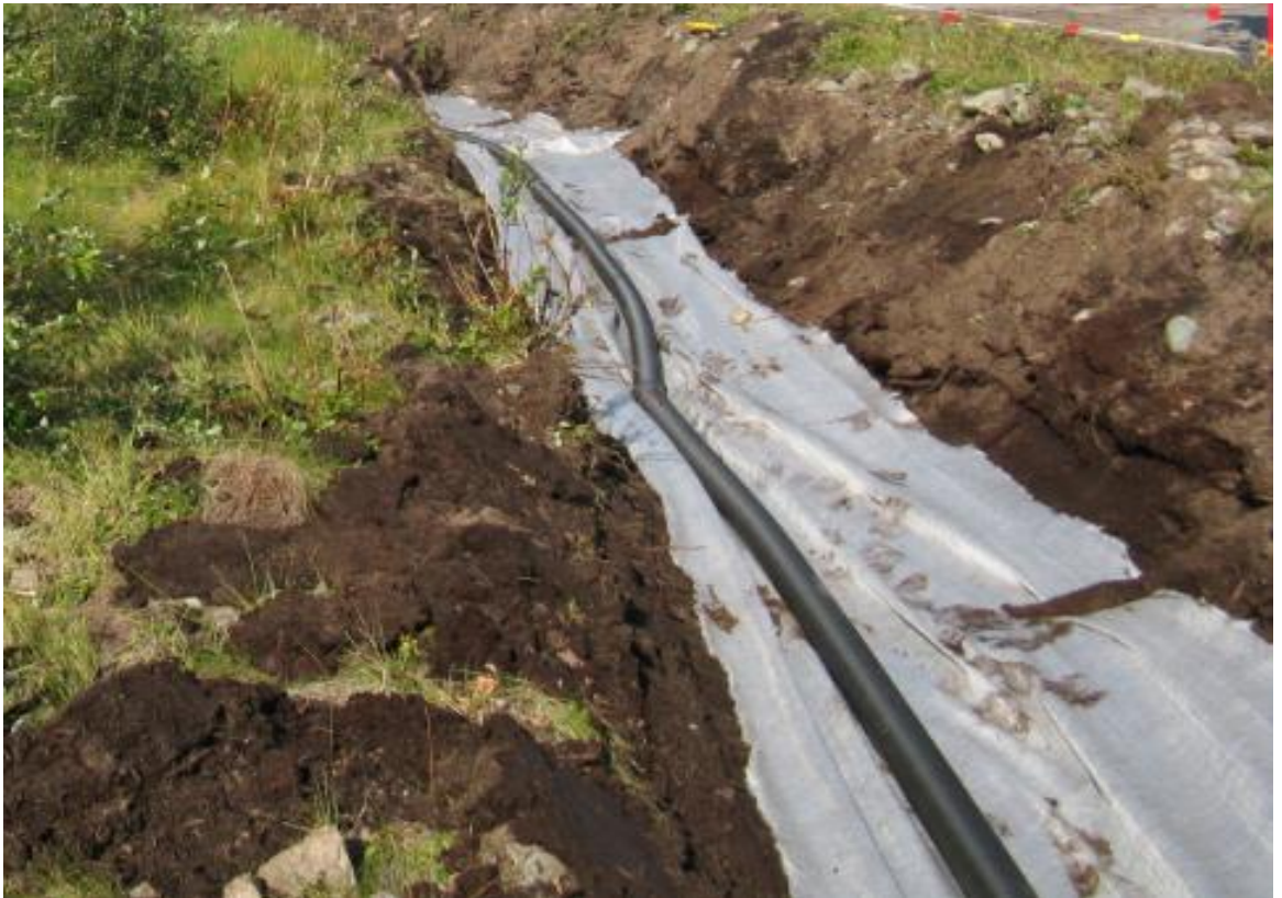
Kuva 11. Kaukolämpö kaivantoon asennettu suodatinkangas ja salaojitus (Kuva: Henri Annala).
