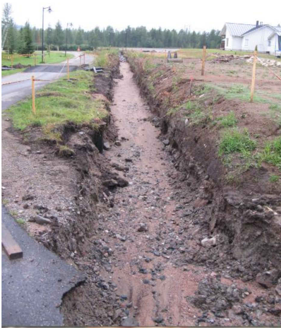
Kuva 1. Rovaniemen Energian kaukolämpökaivanto kesänä 2010 (Kuva: Henri Annala).
