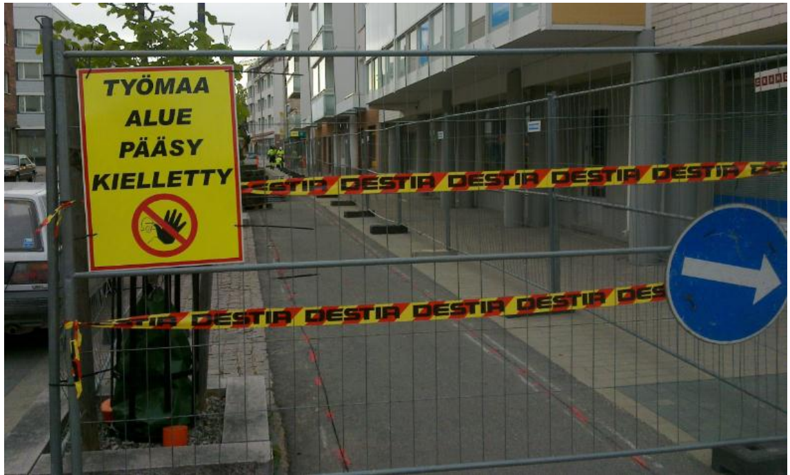
Kuva 8. Rovaniemellä vilkasliikenteisen Rovakadun kevyenliikenteenväylälle kaivettu linja on suojattu työmaa-aitauksella (Kuva: Henri Annala).
