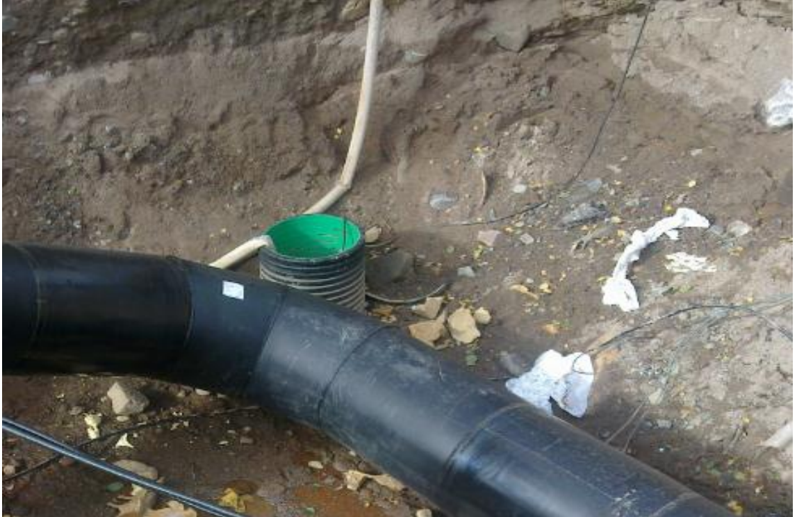
Kuva 10. Kaukolämpö kaivantoon kaivettu pumppauskuoppa. Vesi ohjataan kaivannossa yhteen reunaan, johon on sijoitettu pumppua varten muovi putkesta tehty kaivo. (Kuva: Henri Annala).
