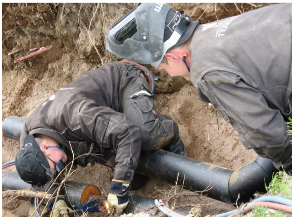
Kuva 2. Putkiasentajalle on jätetty reilusti työtilaa, myös putkien sivuille (Kuva: Henri Annala).
