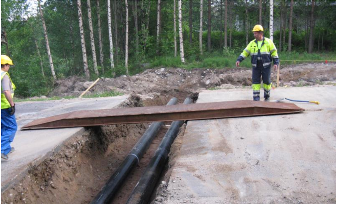
Kuva 9. Rovaniemellä Vaaratien tienkatko ja väliaikaisten siltojen asennus (Kuva: Henri Annala).
