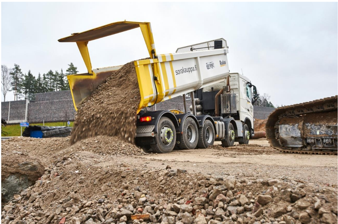
Kuva 7. Maansiirtoauto työmaalla. (Rudus Oy, aineistopankki)
