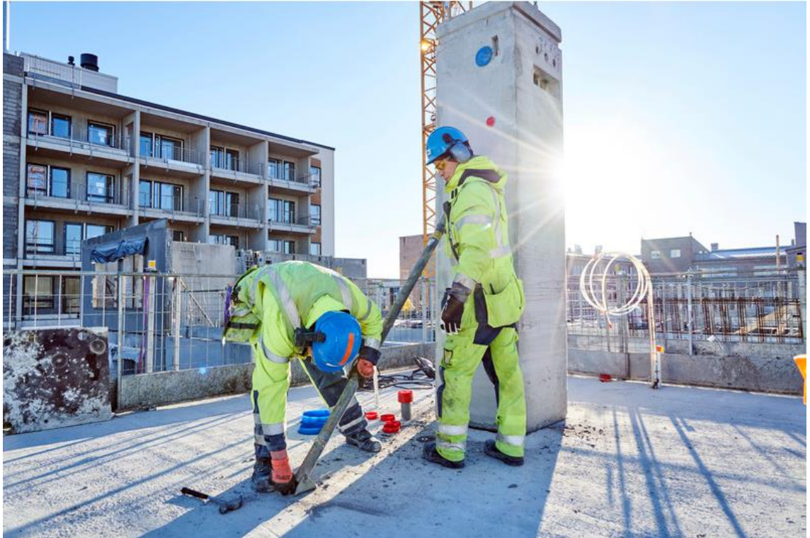
Kuva 3. Elpo-hormin asennus työmaalla (Rudus Oy)
