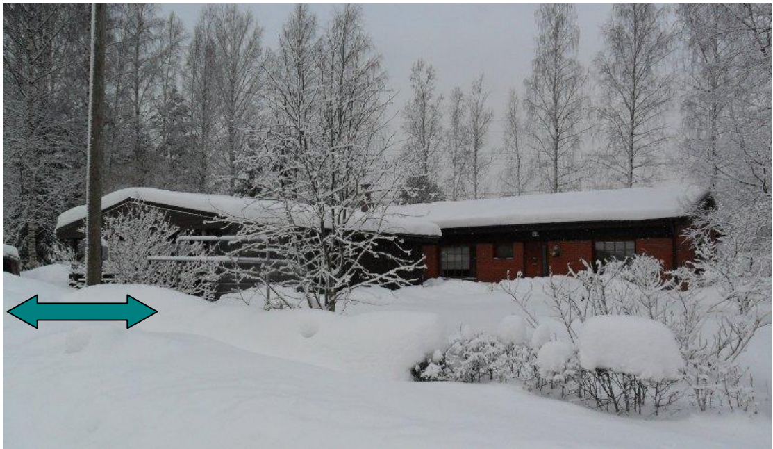
Kuva3. Lämpökanaali kulkee rakennusten 8 ja 5 välissä
