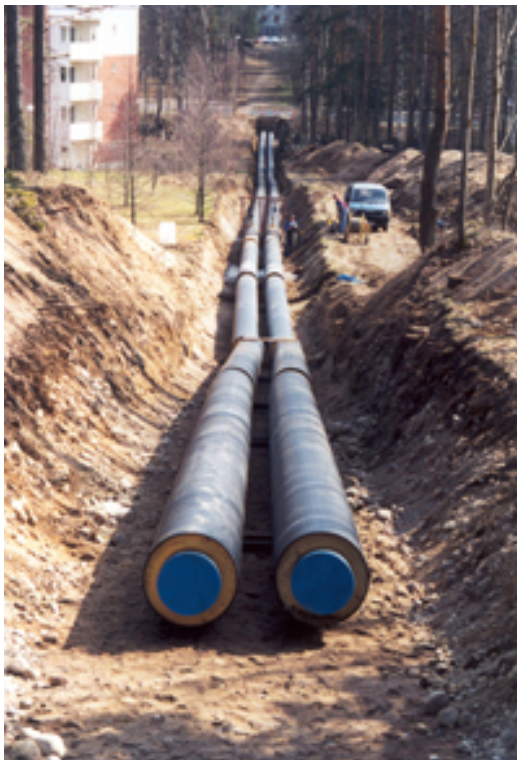
Kuva 16. Meno- ja paluuputki eri suojaputkissa [33.]
