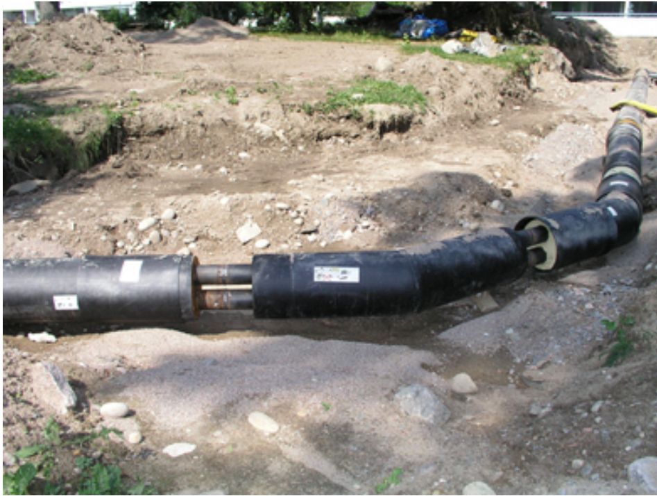
Kuva 15. Meno- ja paluuputki samassa suojaputkessa [33.]
