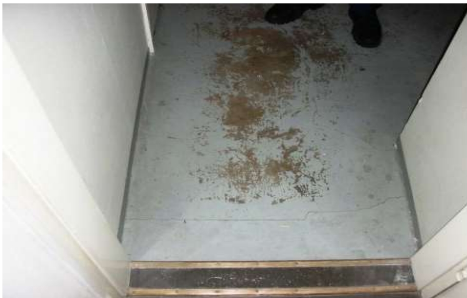
Kuva 16. Kohteen 10 näyte 2, joka on otettu harmaasta lattiamaalista, sisältää PCB(7)-yhdisteitä jopa 27 500 mg/kg. PCB-yhdisteiden kokonaispitoisuus näytteessä oli jopa 135 261 mg/kg, joka on poikkeuksellisen korkea.
