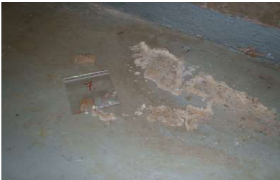
Kuva 17. Kohteen 27 näyte 7, joka on otettu harmaasta lattiamaalista, ei sisällä määritysrajaa 0,70 mg/kg korkeampia pitoisuuksia PCB(7)-yhdisteitä.
