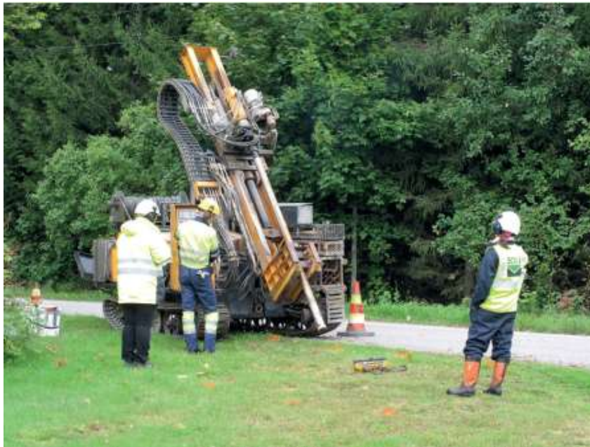
Kuva 10. Raskas porakaira ja työryhmä [39, s. 29].
