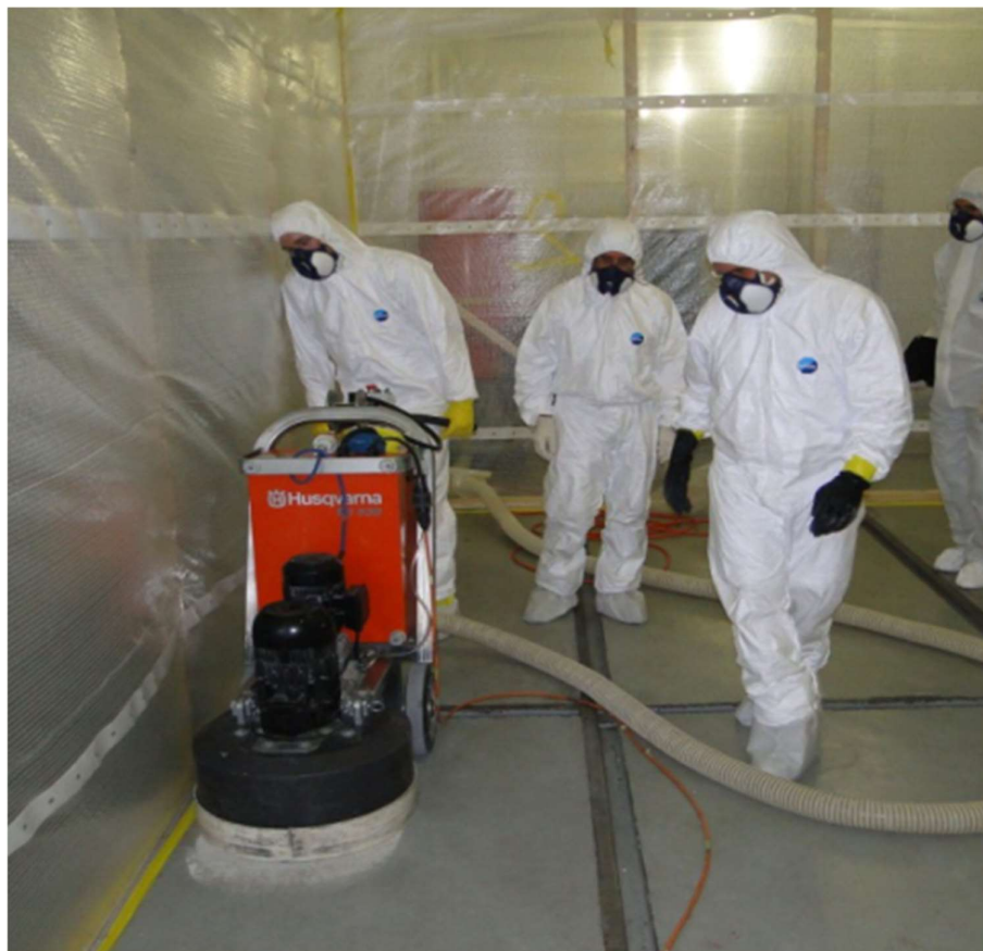
Kuva 14. PCB-yhdisteitä sisältävän lattiapinnan puhdistusta Sveitsissä [25, s. 4].
