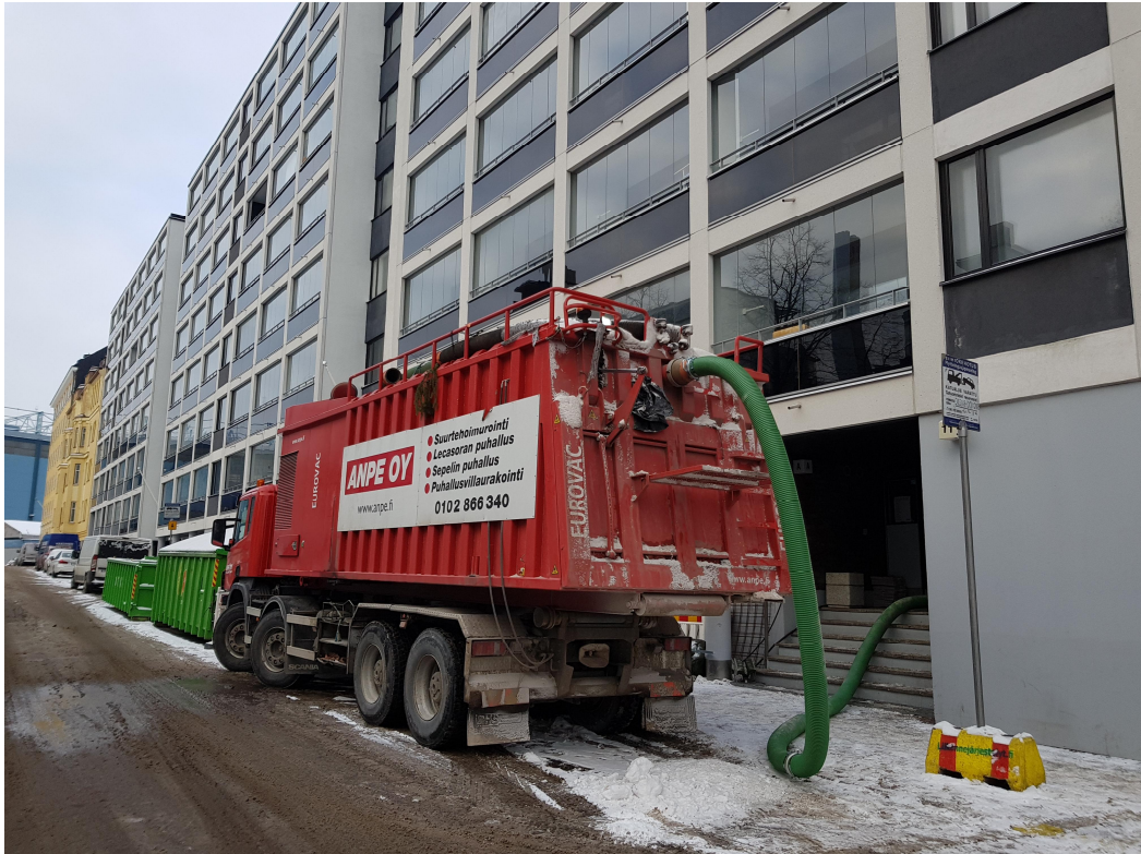
Kuva 5. Työmaalta otettu kuva imuautosta
