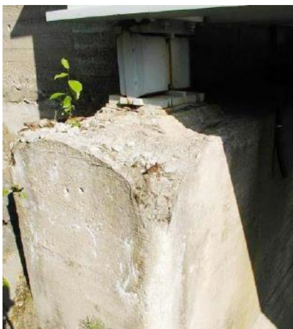
Bild 6. På lagerhylla finns jord och växtlighet så väl som kraftiga korrosionsskador. I detta fall ger inspektören två anmärkningar (B och D). (Tiehallinto 2009)
