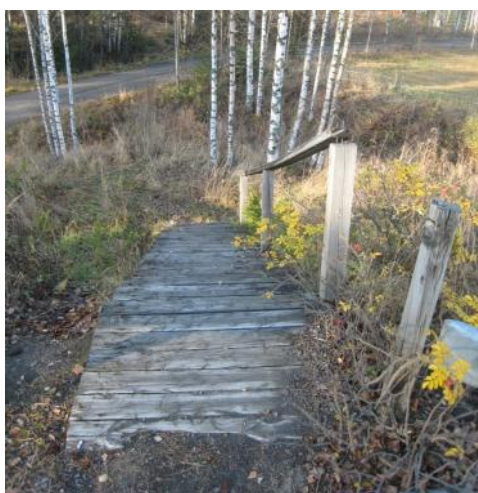
Bild 24. Till vänster en trappa i behov av underhåll (C-anmärkning) Till höger en trappa som är i gott skick (A-anmärkning (Tiehallinto 2009)
