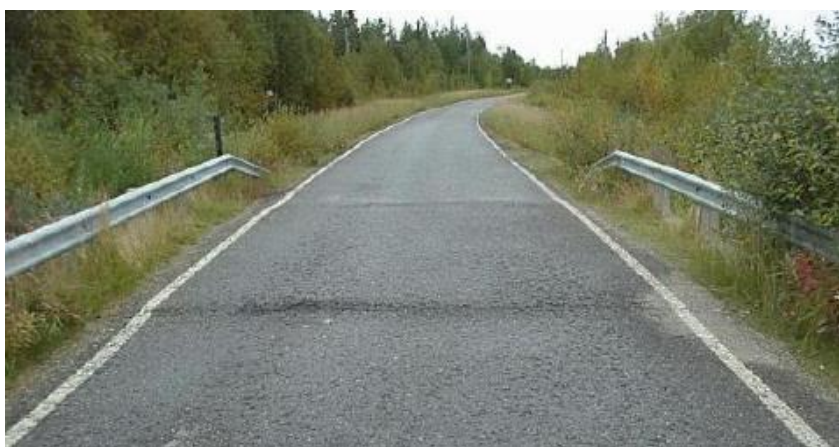
Bild 12. En märkbar tröskel har bildats, men har ej åtgärdats tidigare (C-anmärkning) (Tiehallinto 2009)
