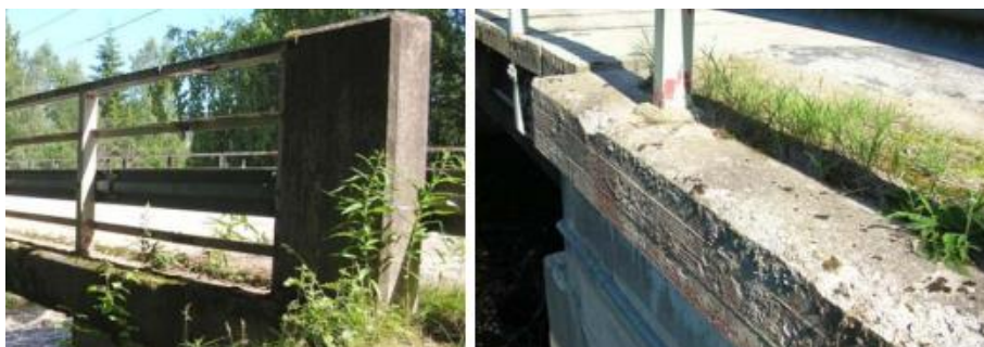
Bild 4. Jord och växtlighet har tillåtits samlas på markstöden (B-anmärkingar) (Liikennevirasto 2014)
