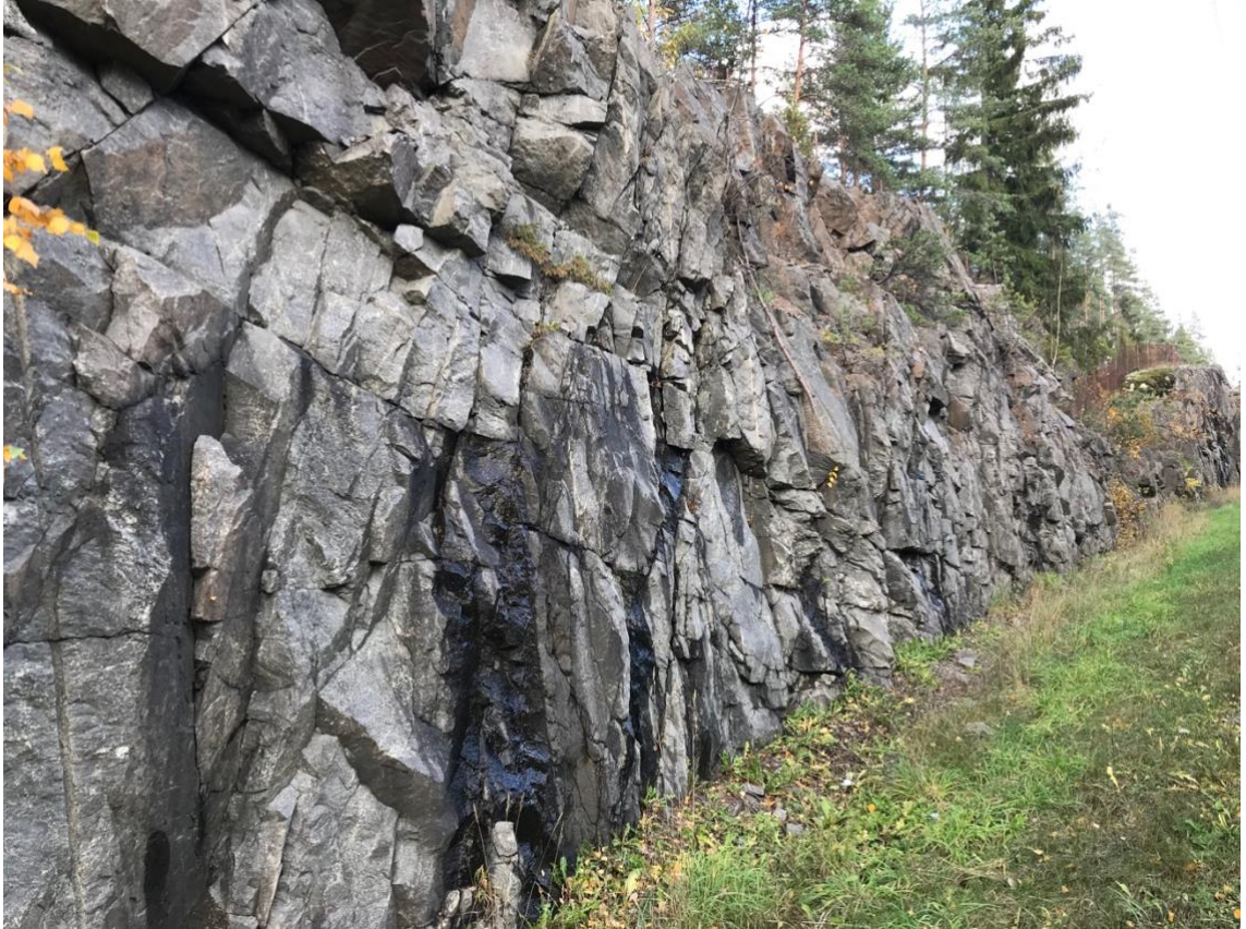
Kuva 11. Vesi valuu kallion halkeamista.
