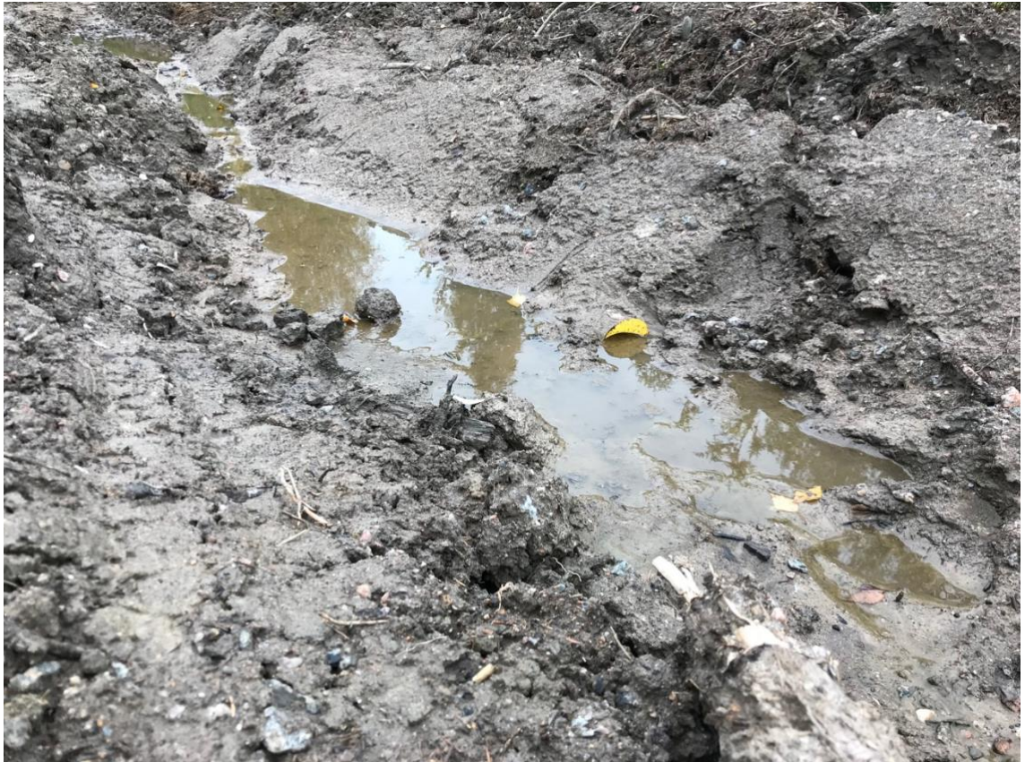
Kuva 8. Savista maata työmaalla.
