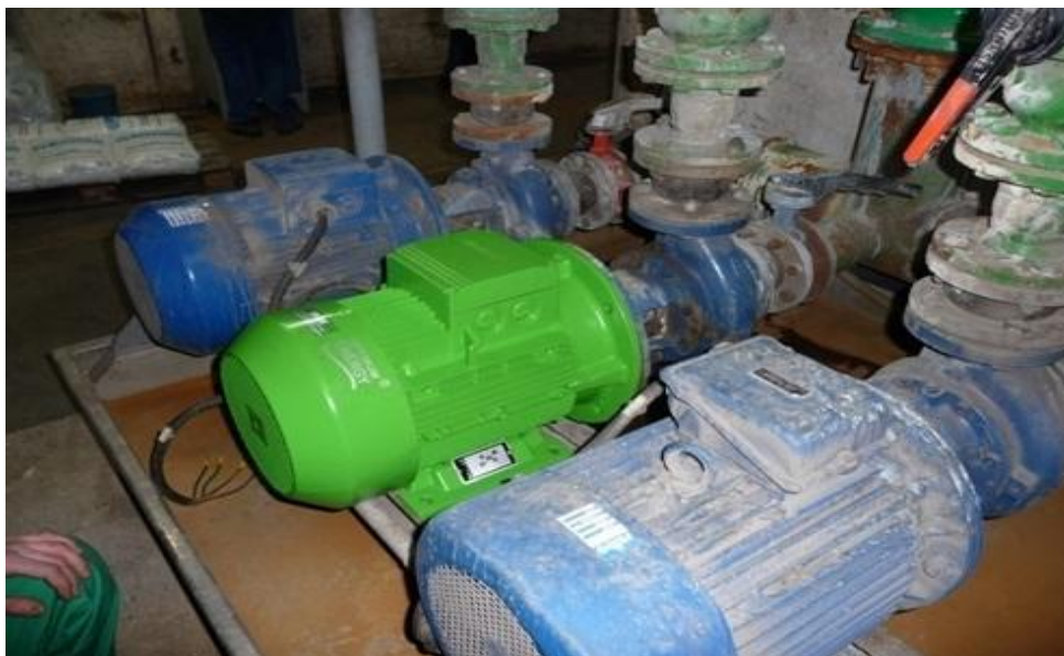
KUVIO 8. Pumppuja pyörittäviä oikosulkumoottoreita. (Optimum Energy 2011.)
