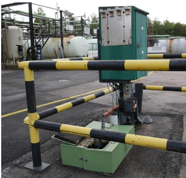
Kuva 2. Katalyyttikoetehtaan öljyisen veden keräilykaivo.
