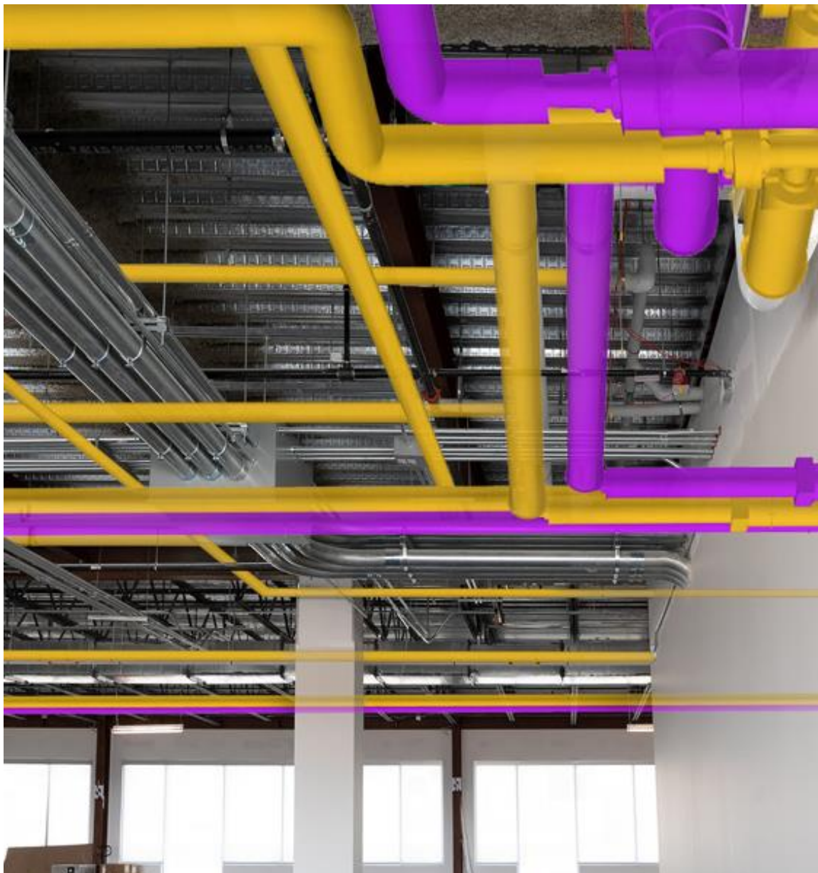
Kuva 6. Putkiston pohjapiirustus visualisoituna rakennustyömaalla. [14]
