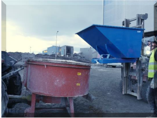
KUVA 5. KUONAN JA MURSKEEN SEKOITUKSEN JÄLKEEN LISÄTTIIN ALITE-ALKALISEOS.
