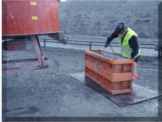
KUVA 8. MUOTTIÖLJYN RUISKUTUS MUOTTIIN
