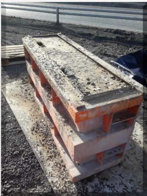
KUVA 12. BLOKI 2 ON 4 VRK:N JÄLKEEN VIELÄ MUOTISSA.
