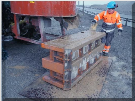
KUVA 10. PINNAN VIIMEISTELY HIERTÄMÄLLÄ.
