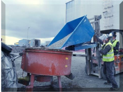
KUVA 2. SEKOITIMEEN LISÄTTIIN ENSIN MURSKEET.
