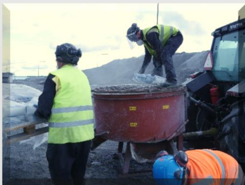
KUVA 4. MURSKEEN JÄLKEEN LISÄTTIIN MASUUNIKUONAJAUHE.
