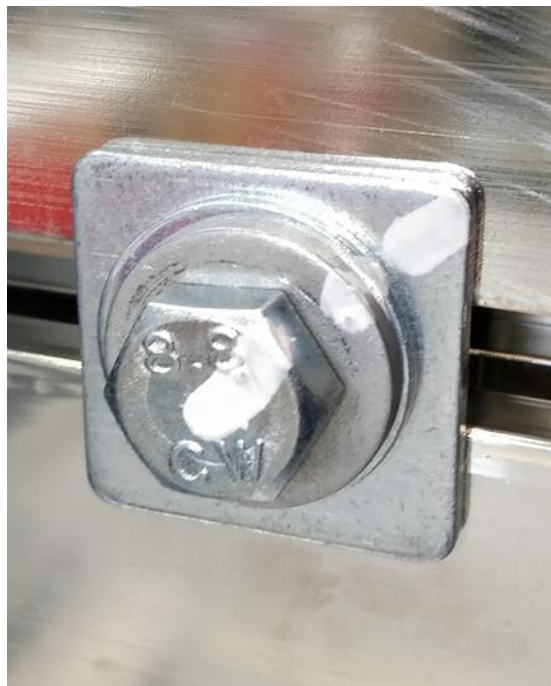
Kuva 4. Kiristetty virtaliitos.
