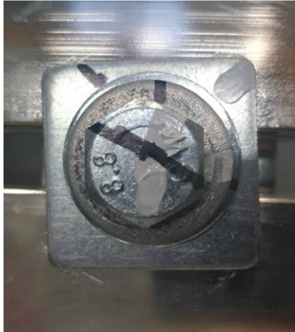
Kuva 6. Virheellinen virtaliitos.
