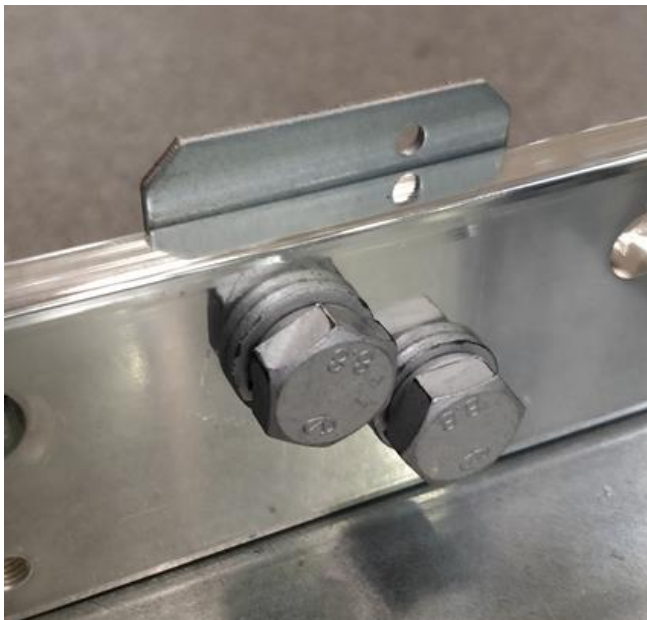
Kuva 2. Maadoituskiskon momenttiliitos combiruuvilla.
