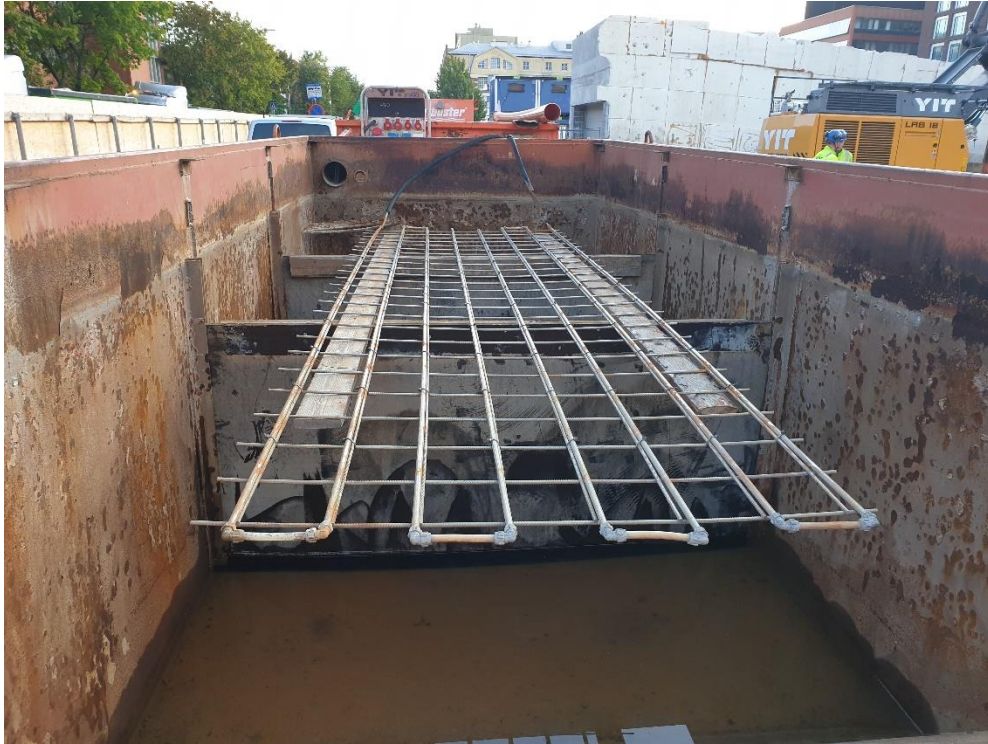
Kuva 9. Yllä kuva yhden altaan sisältä.
