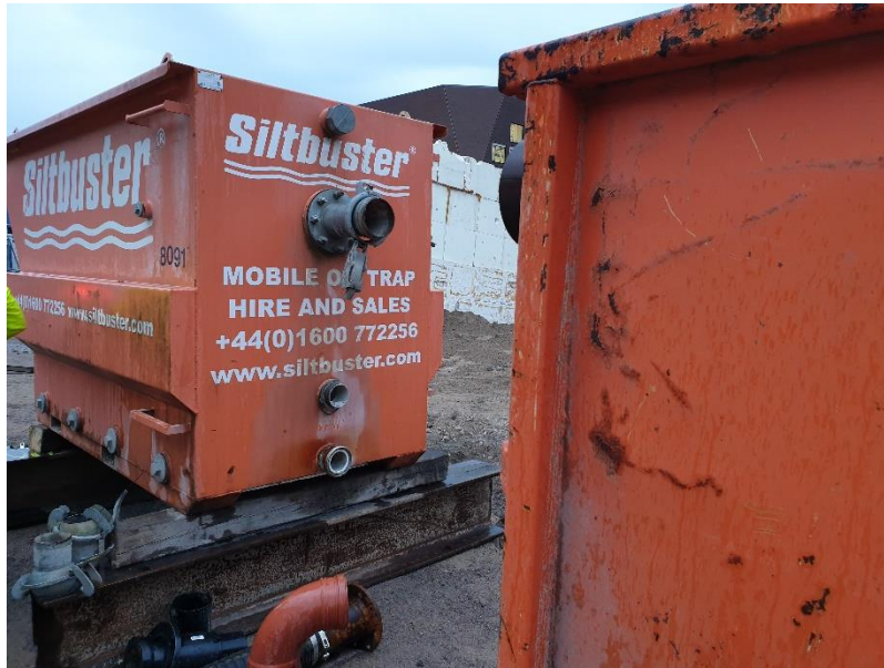
Kuva 5. Tilanne ennen putkien asentamista
