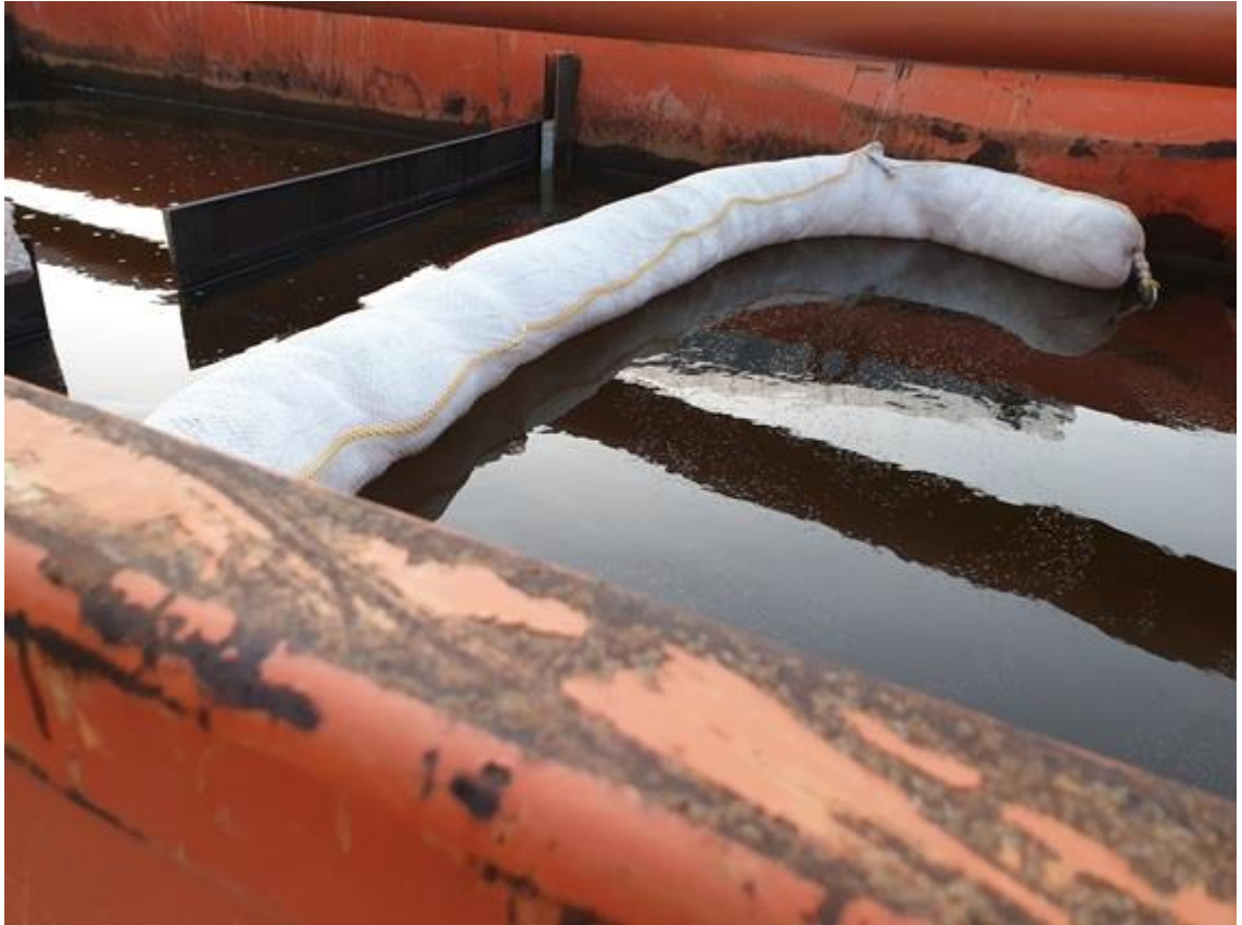
Kuva 24. Tasausaltaaseen asennettu puomi pumppauksen aloituksen jälkeen
