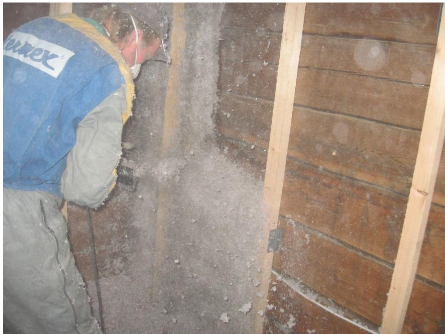
Kuva 32. Seinien lisäeristystä selluvillalla.
