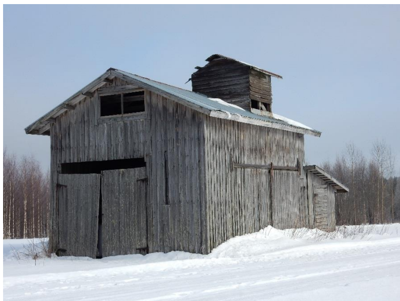
Kuva 38. Kuivaamokäytössä ollut savusaunarakennus. (Kolunsarka 2016.)
