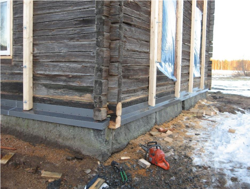
Kuva 28. Vesipellit ja följärit asennettu.
