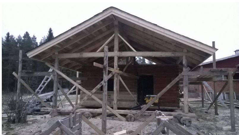
Kuva 51. Terassin runkorakennetta. (Nelimarkka 2016.)
