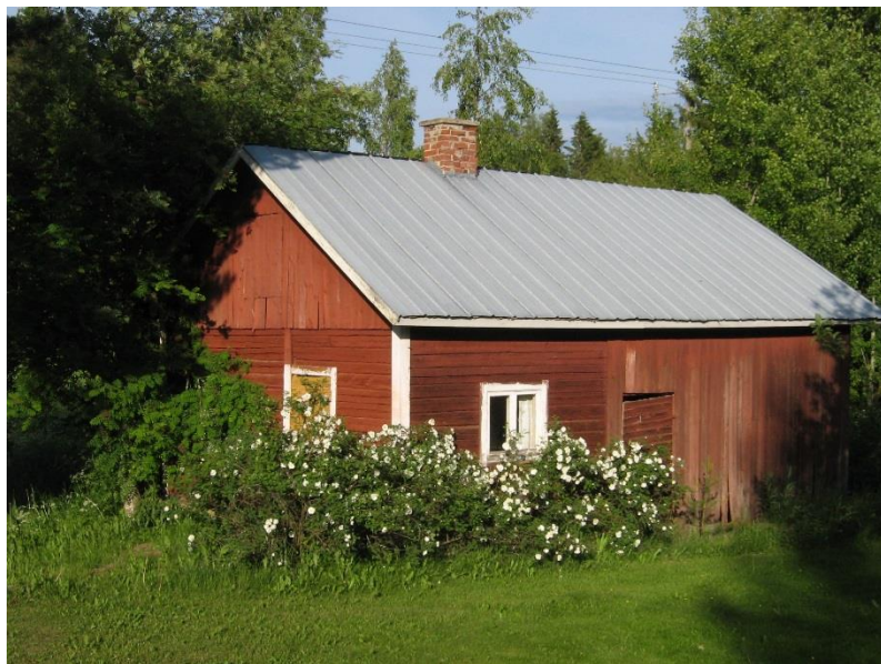
Kuva 49. Alkutilanne ennen remonttia. (Nelimarkka 2016.)
