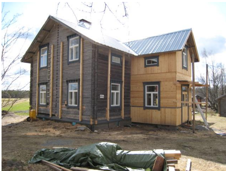
Kuva 35. Ikkunat ja vuorilaudat paikoillaan ja kuistin panelointi tehtynä.
