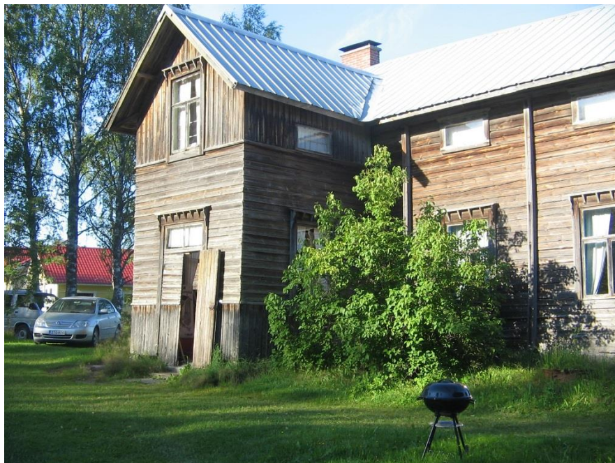
Kuva 15. Aloitustilanne ennen remonttia.
