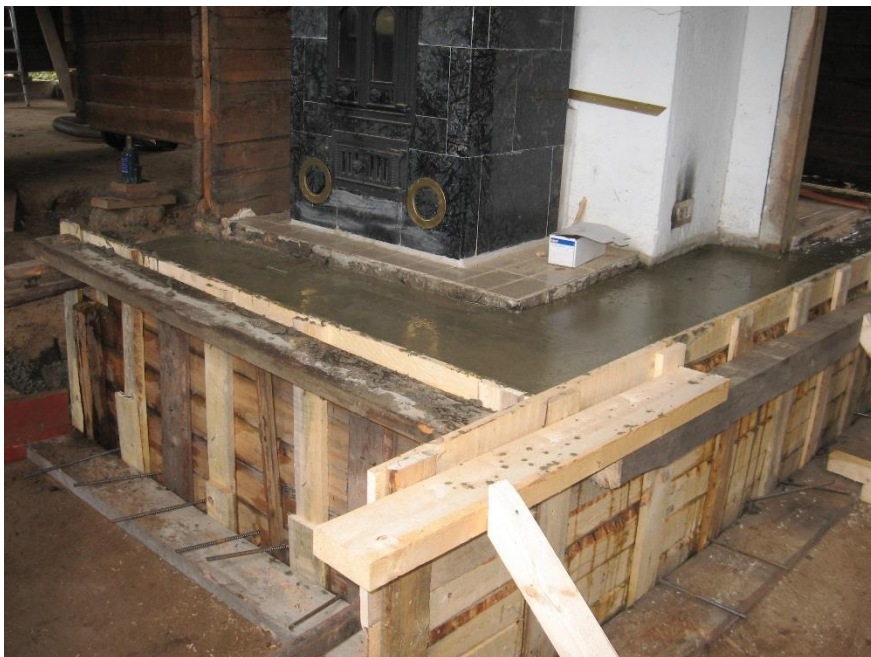
Kuva 30. Tulisijan perustuksen vahvistusvalu.
