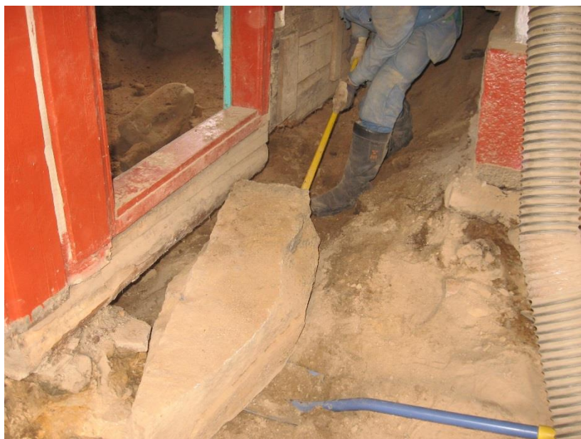
Kuva 19. Leivinuunin takaosan purkua.
