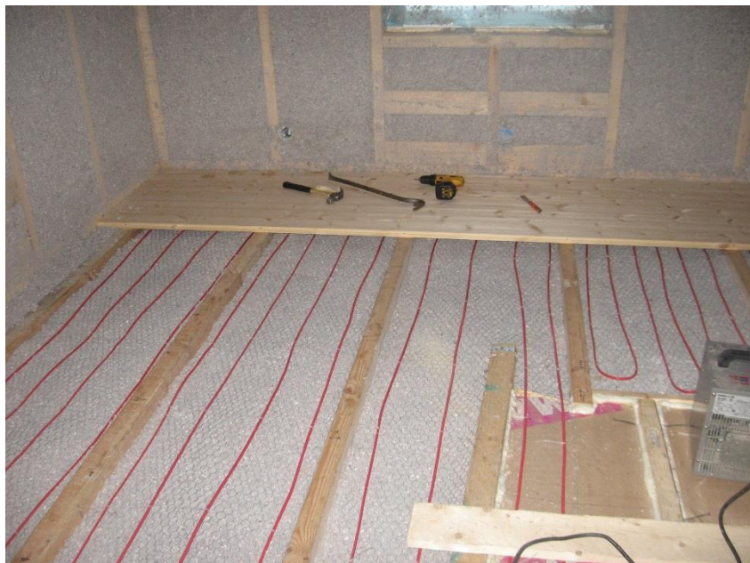
Kuva 33. Kamarin lattialämmityksen toteutus.
