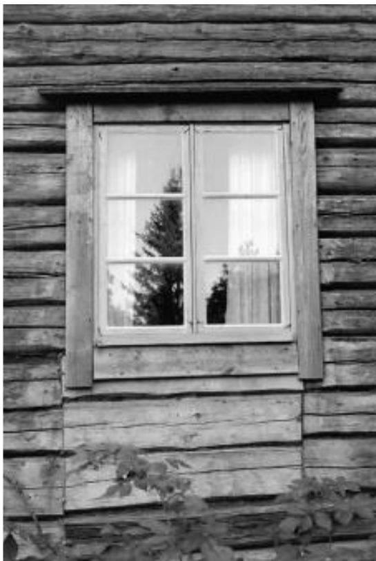
Kuva 14. Ikkunan aluspuiden korjauskohta. (Puurunen 1995, 9.)
