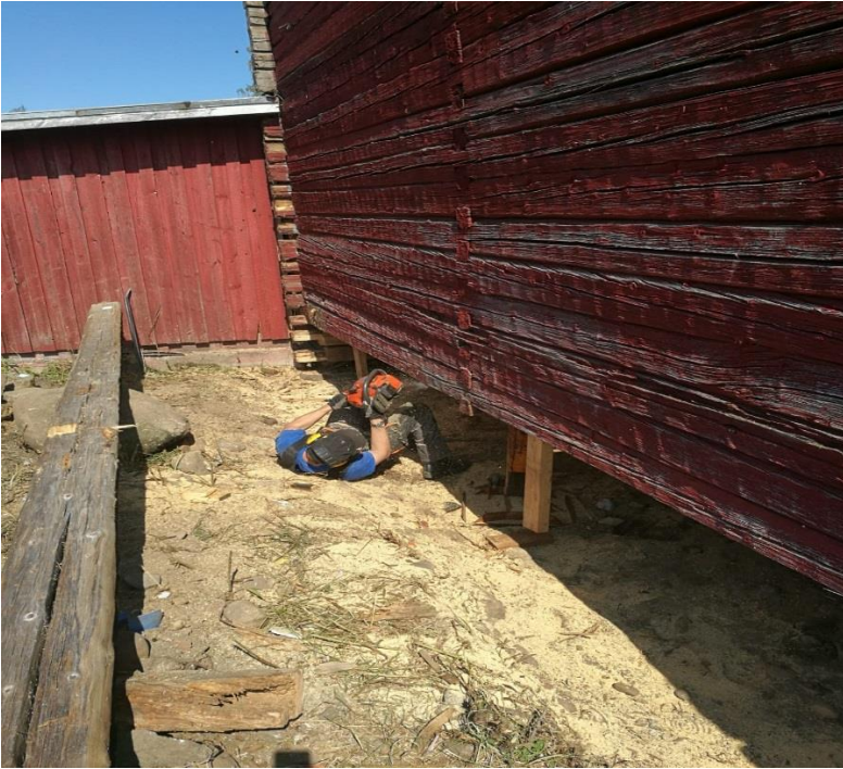
Kuva 25. Ensimmäisen vaihdettavan hirren sovitussahausta eri työmaalta kuvattuna.
