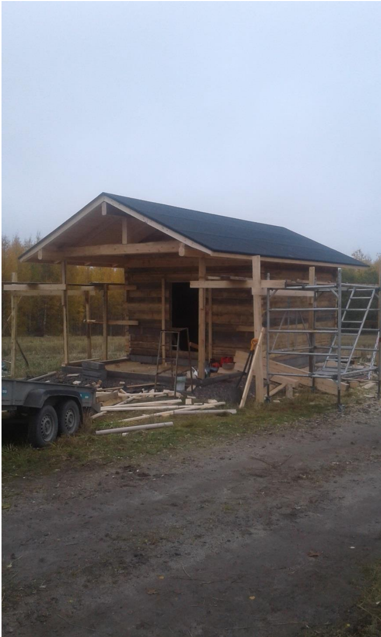
Kuva 44. Kehikko valmis ja huopakatto tehty.
