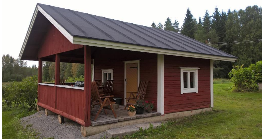
Kuva 52. Rakennus valmiina uuteen käyttötarkoitukseen ajateltuna. (Nelimarkka 2017.)
