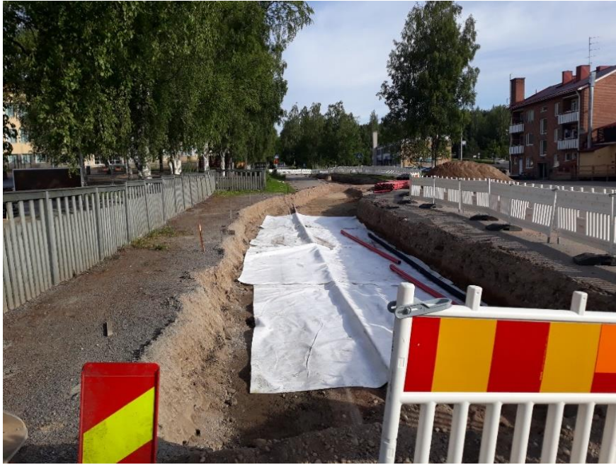
Kuva 1. Suodatinkankaan limitys ja asentaminen.
