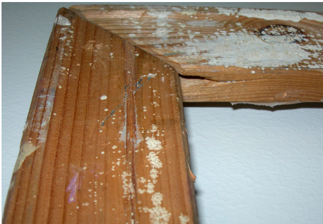
KUVA 53: Oikean alakulman halkeama vahvistettiin puuliimalla.
