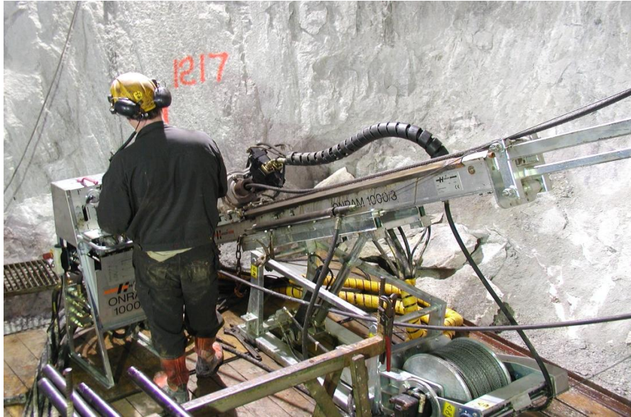
KUVA 1 Kallionäytekairausta (kuva Suomen Malmi Oy).
