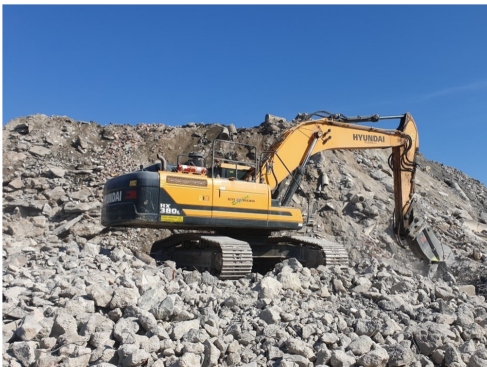
Kuva 4. Betonimurskeen pulverointi (Rudus 2019)
