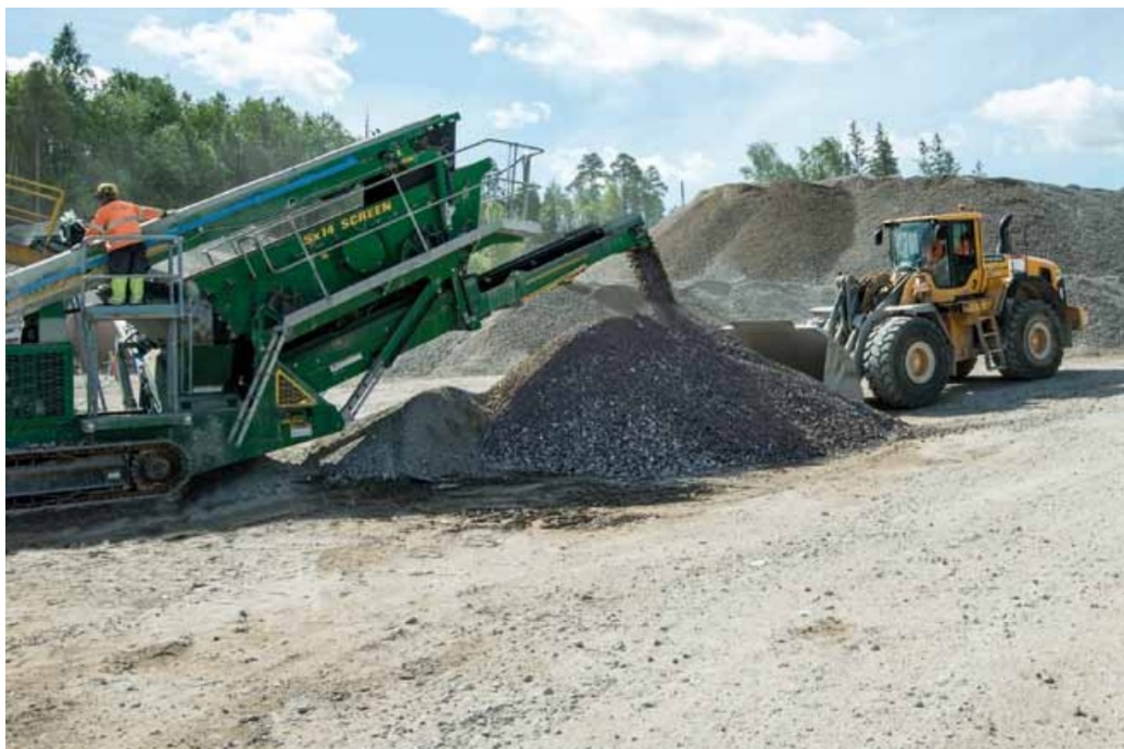
Kuva 5. Betonimurskeen valmistusta (Rudus 2017)
