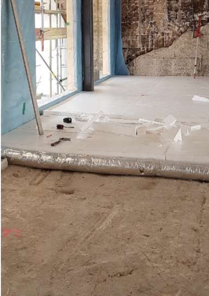
Kuva 13. Uuden välipohjan eristäminen.
