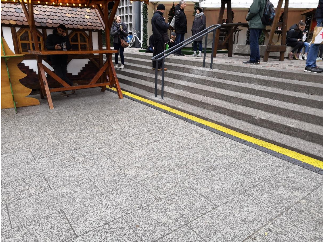
Kuva 14. Kaapelisuoja porrasten jatkeena.
