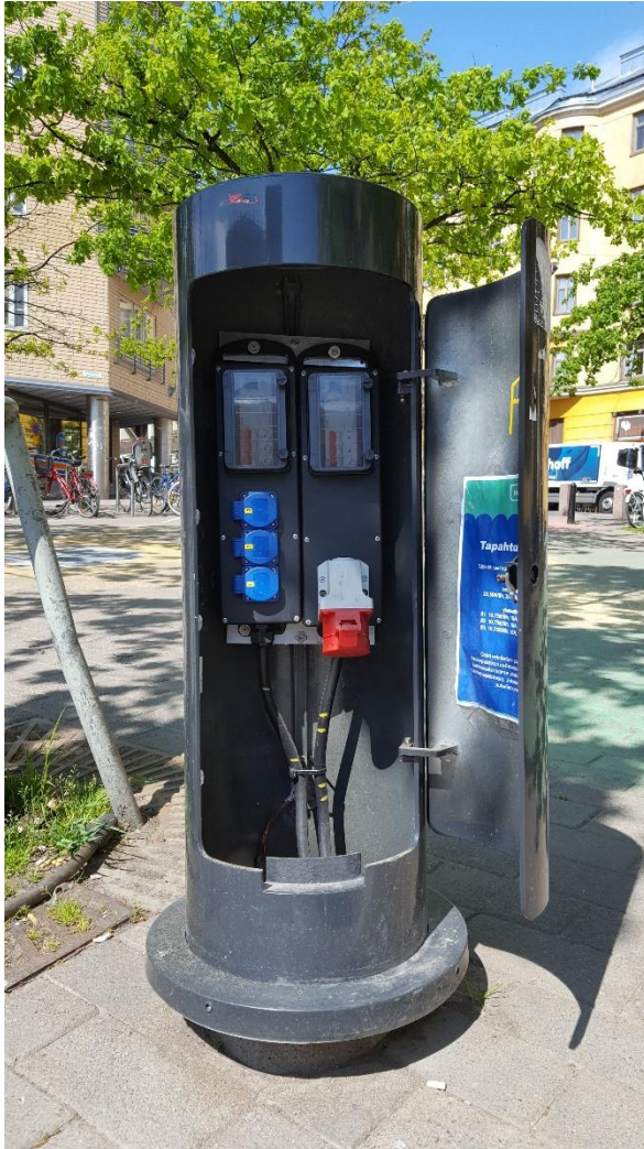
Kuva 13. Vaasanpuistikon tapahtumasähköpiste.
