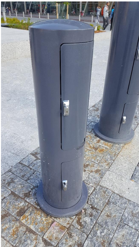
Kuva 19. Kansalaistorin tapahtumasähköpollari ja iLOQ S10 -avainpesät.
