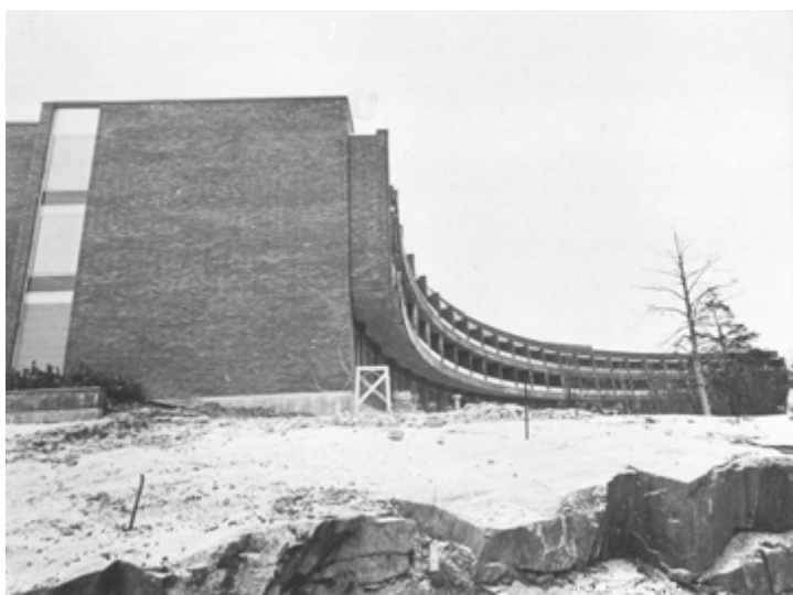
Valokuva 8. Uudesta hotellista tuli tyylikäs. Julkisivut verhoiltiin tummanruskealla julkisivutiilellä.
