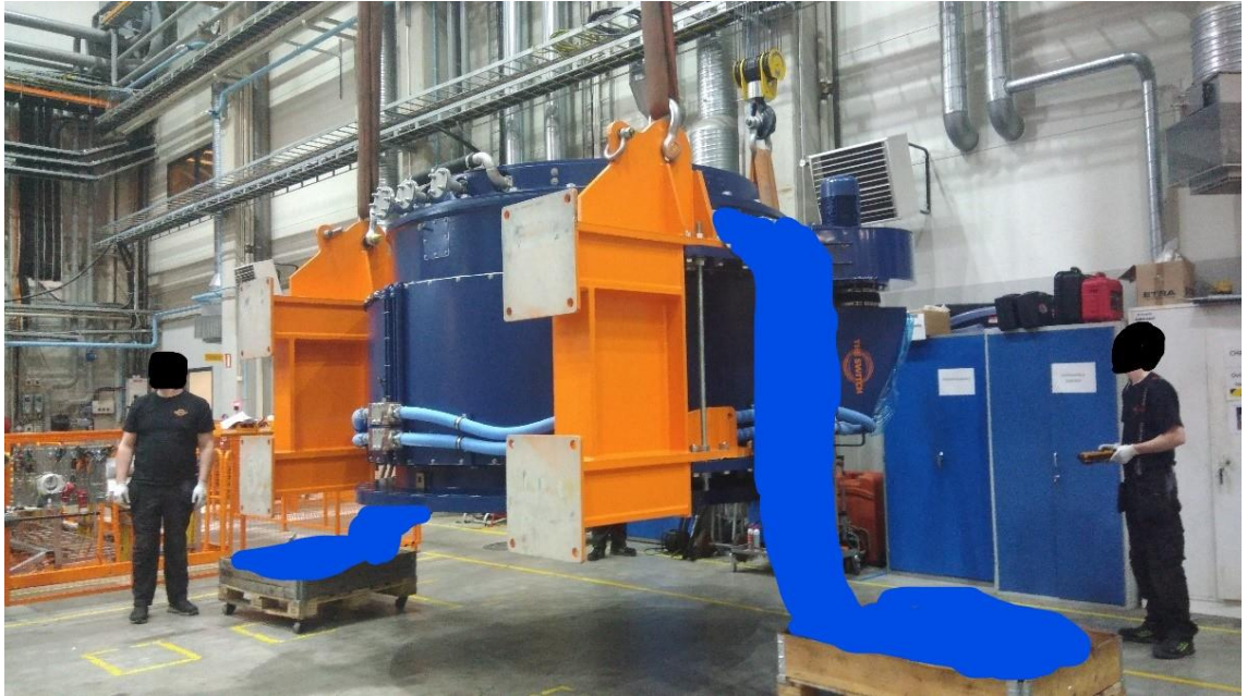
Kuva 16. Generaattori valmiina kääntö varten (Juho Kallio 2019)
