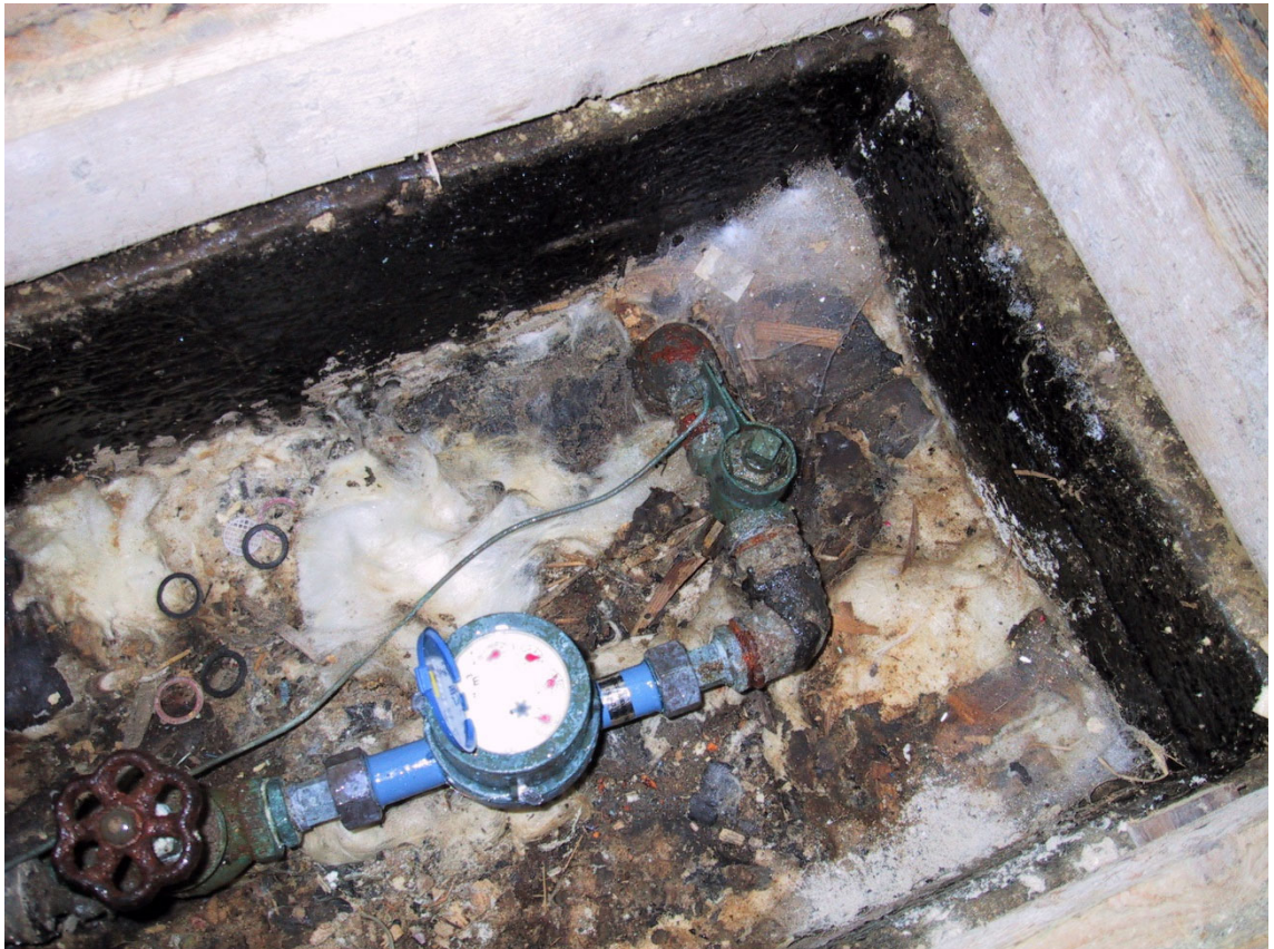
Kuva 4. Uusimiskunnossa olevia vesimittarin liitososia (Forssan vesihuoltoliikelaitos).
