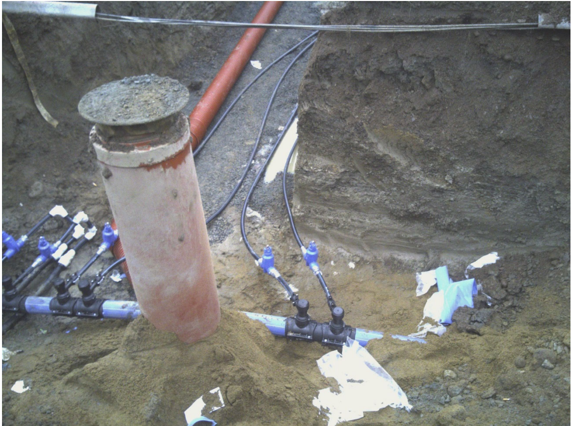
Kuva 2. Vesihuoltosaneeraustyömaa Forssassa (Forssan vesihuoltoliikelaitos).
