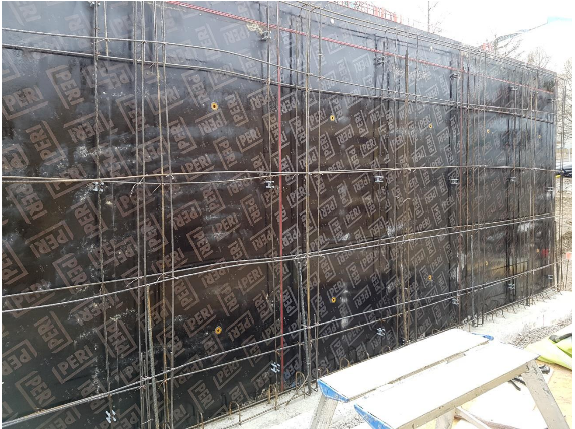
Kuva 3. Raudoitettu väliseinä muotti.
