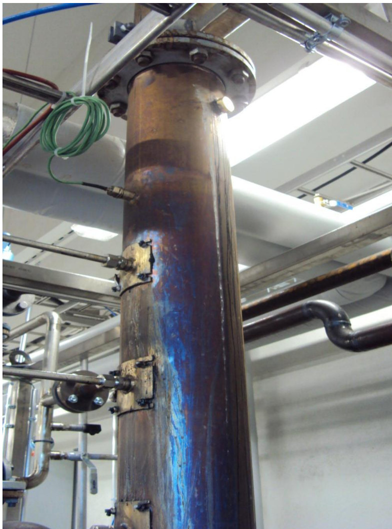
Kuva 22. Kattilan savukaasukanava. Savukaasujen mittauspiste sijaitsee heti pesurin jälkeen.
