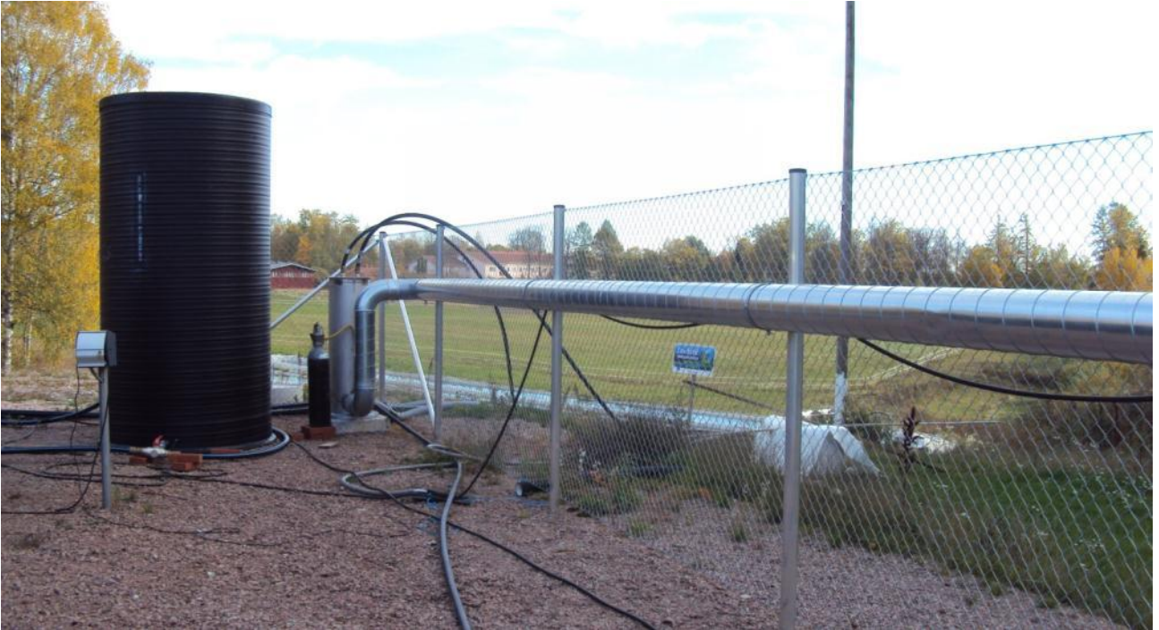
Kuva 20. Nurkassa oleva torni on levänerottelutorni. Oikealla savukanava kattilasta, josta hiilidioksidi (CO 2 ) johdetaan leville ravinnoksi.
