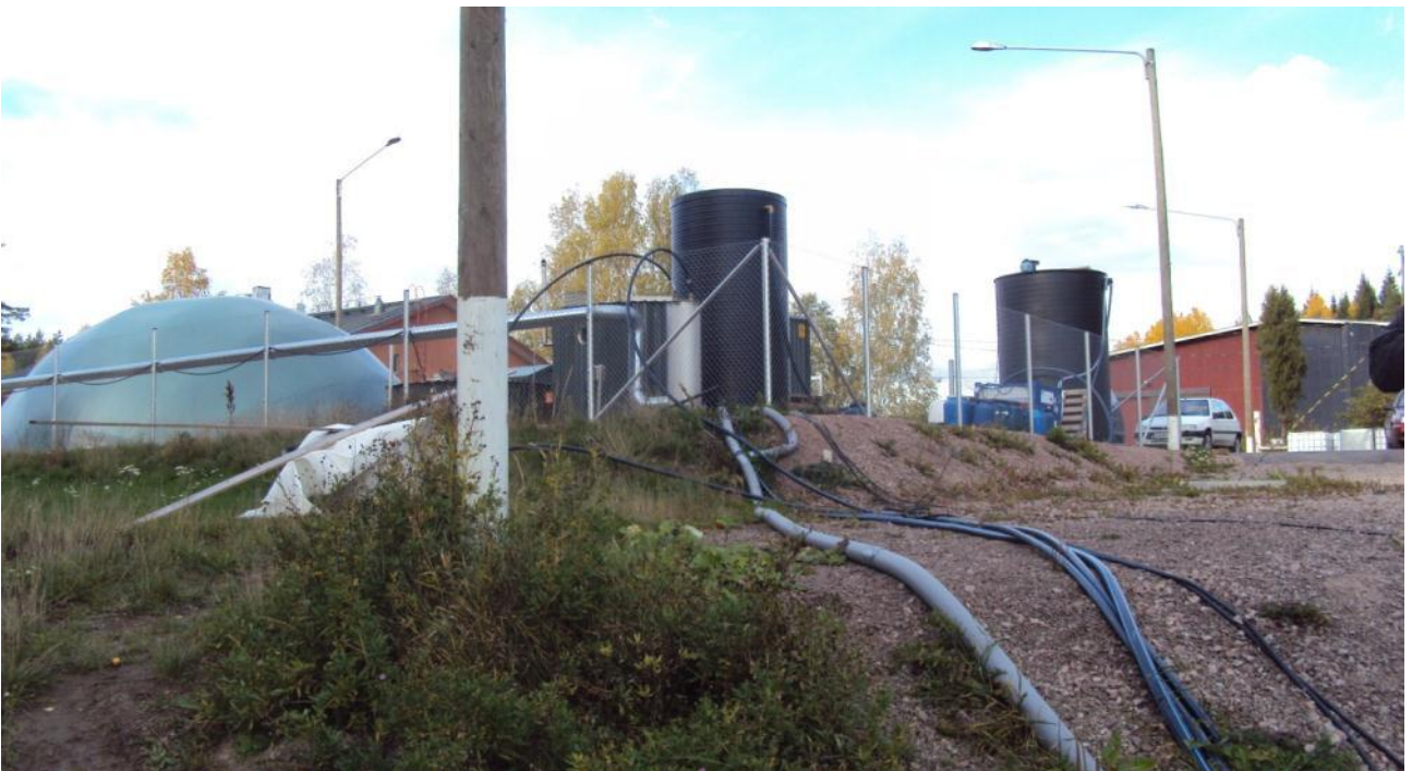
Kuva 21. Savukaasuista johdettava hiilidioksidi johdetaan mustasta hiilidioksidin keräilyastiasta leväaltaaseen harmaata putkea pitkin. Lisäksi kuvasta näkyvät vedensyöttöletkut levänkasvatusaltaaseen.
