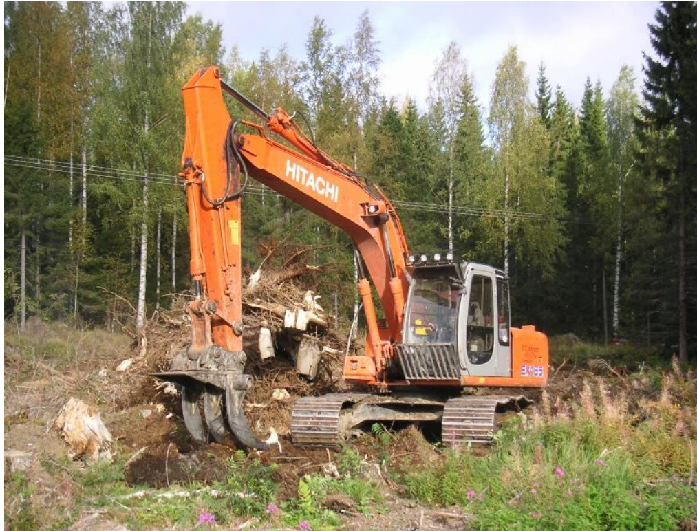
KUVA 1. Tela-alustainen kaivinkone, jossa muokkauslevyllä varustettu kantoharra (Leinonen 2009).
