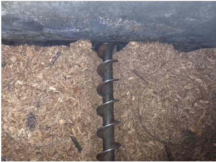
KUVIO 27. Kuva varastosilosta polttokokeen loppuvaiheessa
