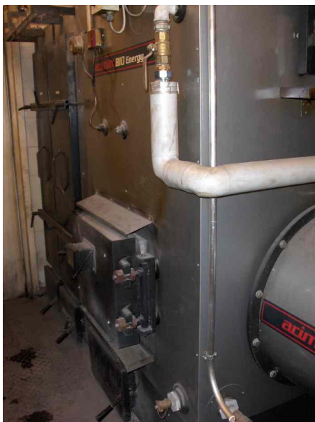
KUVIO 7. Arimax BIO energy -kattila ja BioJet -palopää
