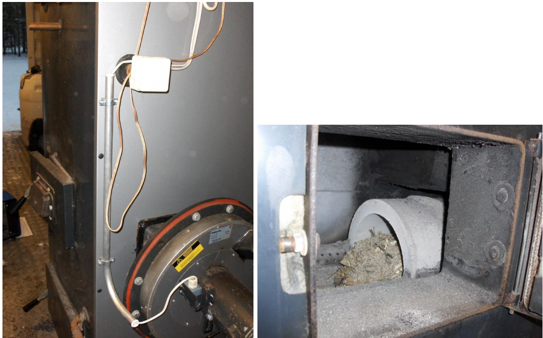
KUVIO 4. Arimax 360 BIO energy -kattila ja HakeJet -palopää
