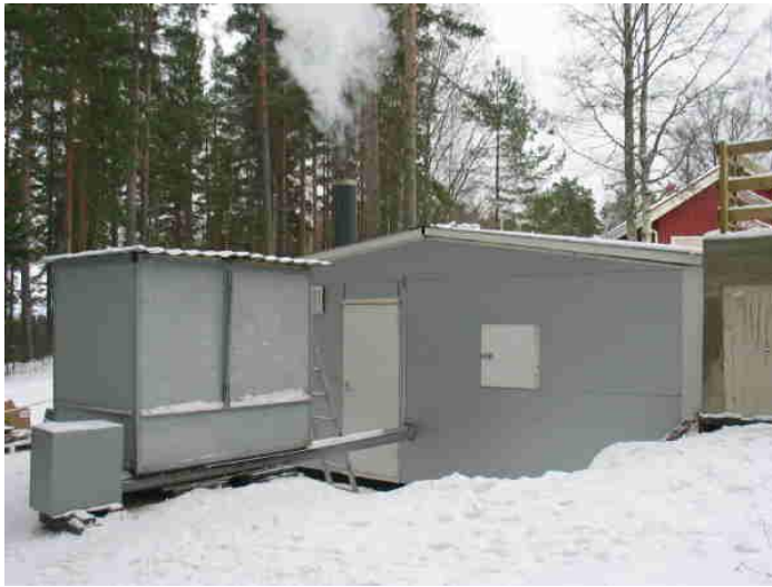
KUVIO 42. Sivusyöttölaitteen sijoittuminen (Vilkkilä 2008)
