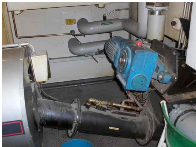
KUVIO 7. Arimax BIO energy -kattila ja BioJet -palopää
