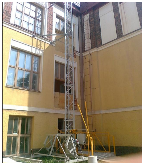
Kuva 2. Kuvassa näkyvän rakennushissin paikalle tulee hissi
