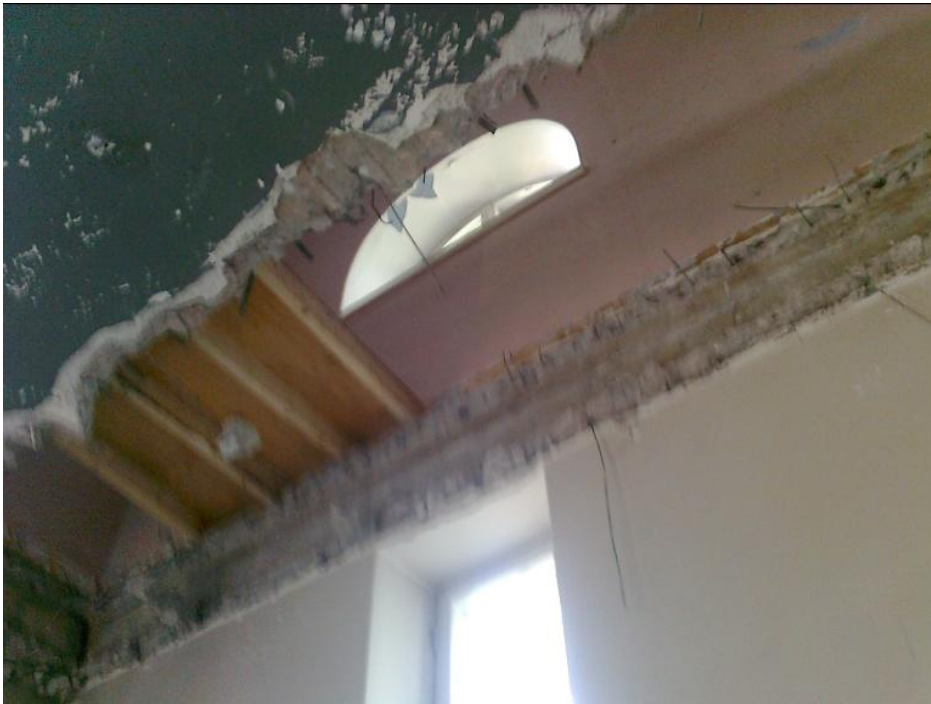
Kuva 9. Yläpohjaa on purettu huonemuutosten vuoksi. Kuvasta on helppo havaita, kuinka paksu yläpohja on
