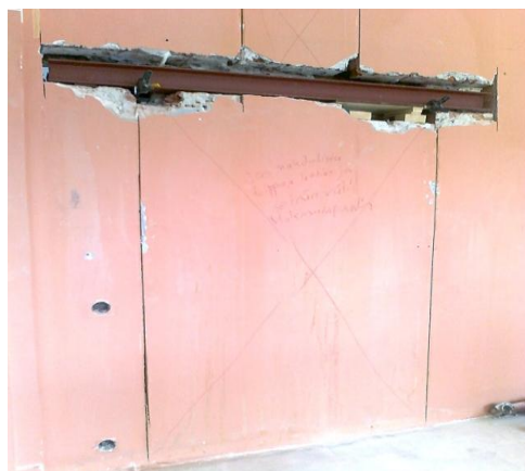
Kuva 6. Seinään tulee aukko IV-koneelle. Seinää on tuettu upottamalla I-palkki
