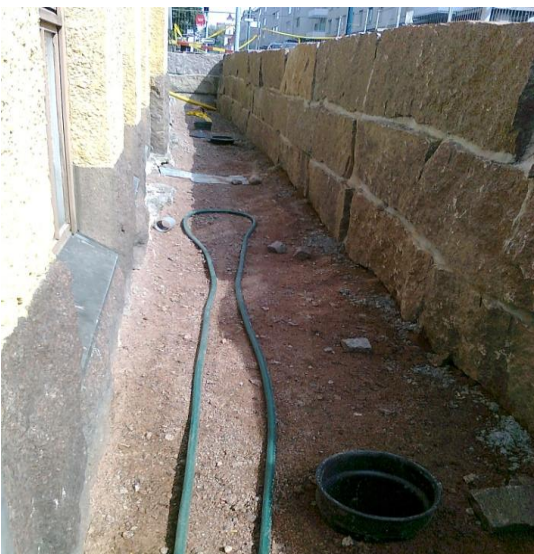
Kuva 1. Rakennuksen vieressä on kivimuuri, joka purettiin ja kasattiin uudestaan sadevesi- ja salaojajärjestelmien uusimisen yhteydessä
