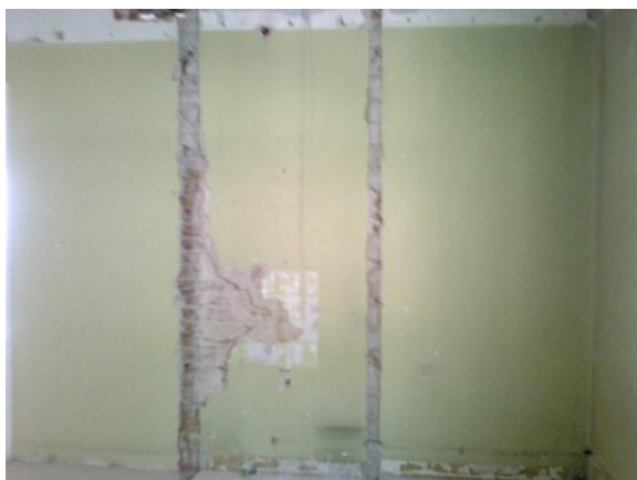
Kuva 5. Vanhoja tiilisiä väliseiniä on purettu pois piikkaamalla
