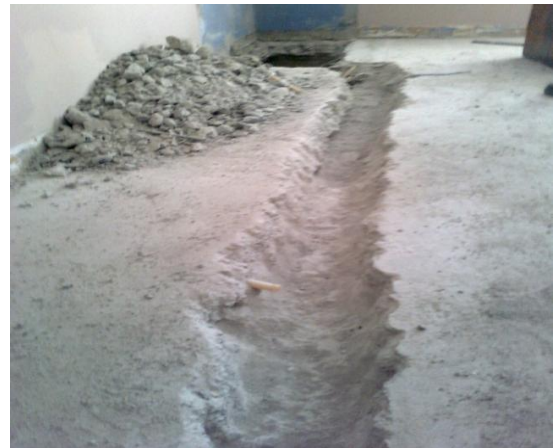
Kuva 8. Välipohjan lattiaan on piikattu railo käsienvesualtaan viemäriputkea varten
