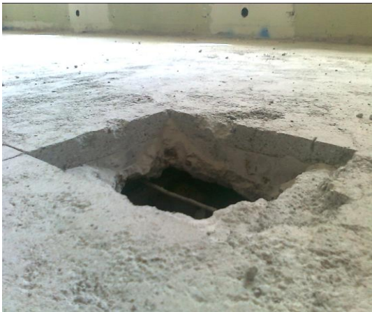
Kuva 7. Kuvasta pystyy erottamaan pintalaatan ja palkistoa
