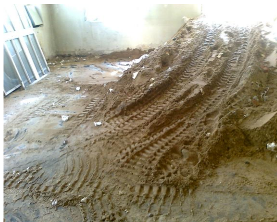
Kuva 4. Oviaukkoa on suurennettu, jotta Bobcat-kaivuri saa vietyä maa-ainesta pois rakennuksen sisältä
