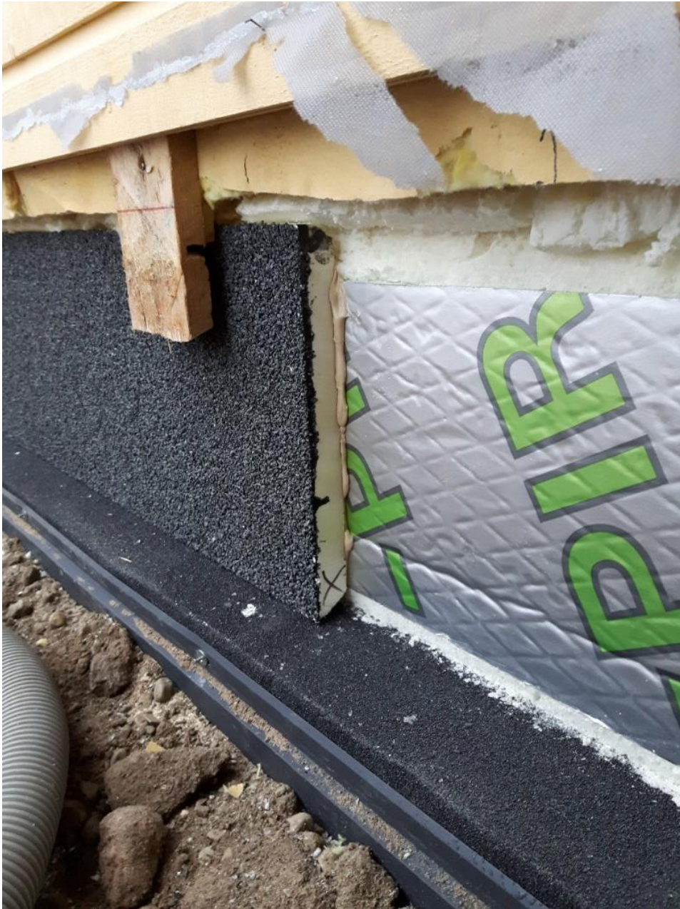
KUVA 12. Sokkelielementin asennus (6.)
