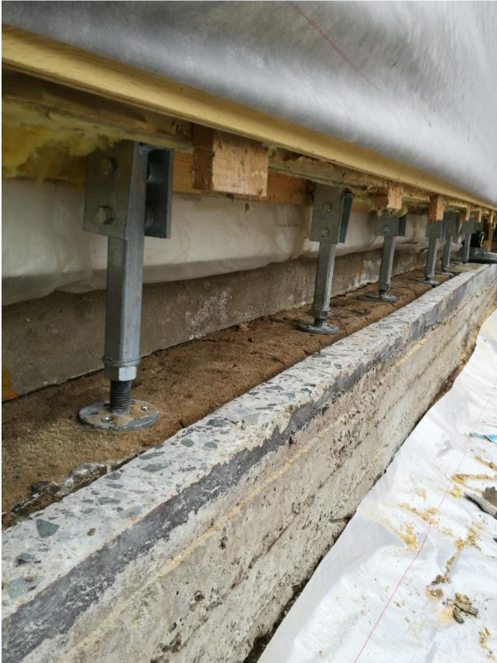
KUVA 8. Säätöjalan asennus (6.)
