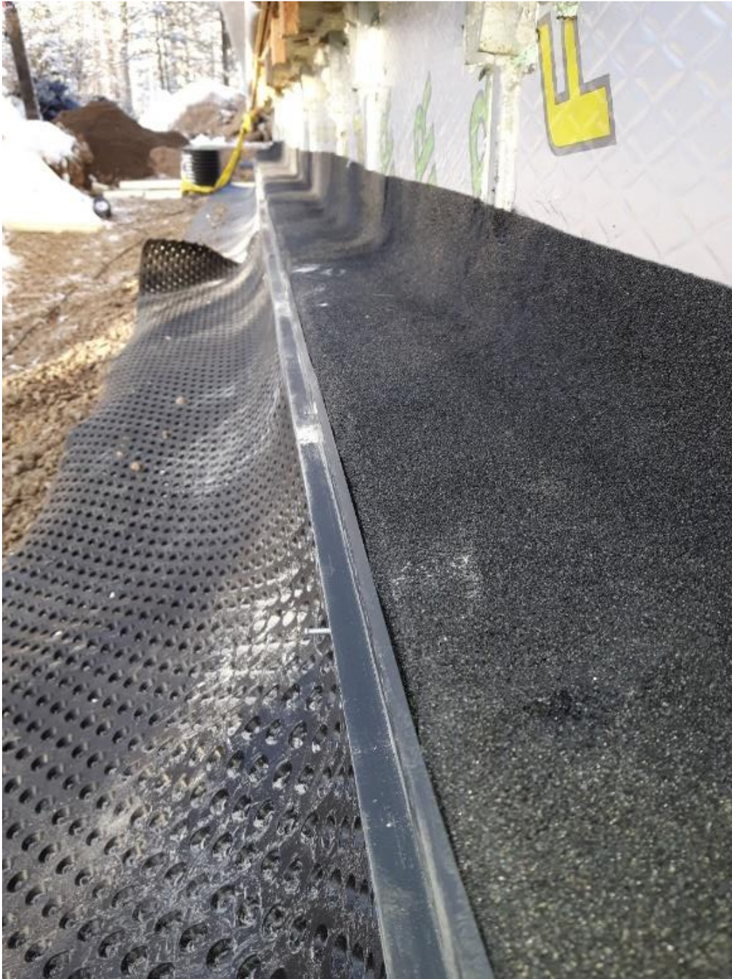
KUVA 10. Bitumikerman asennus (6.)
