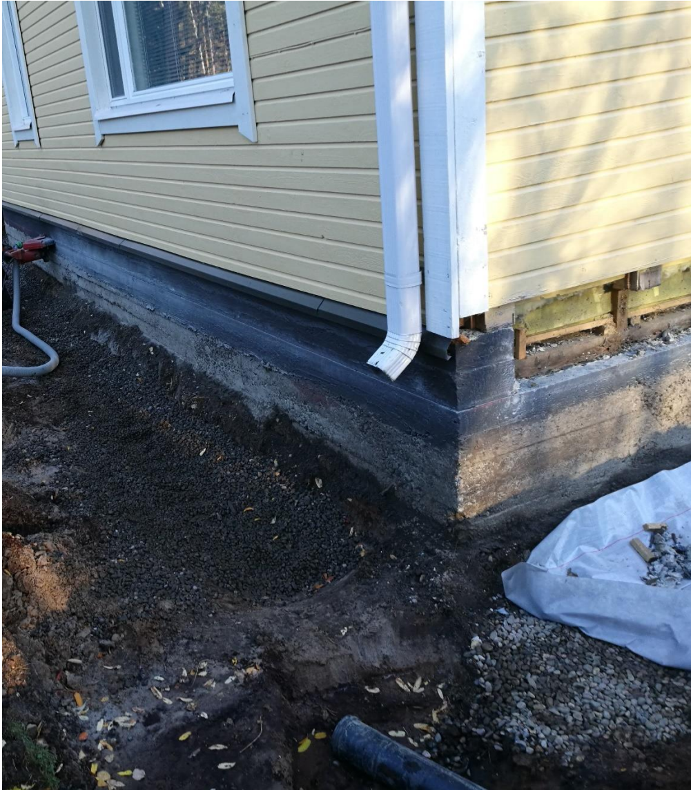
KUVA 5. Valesokkelilevyn halkaisu (6.)
