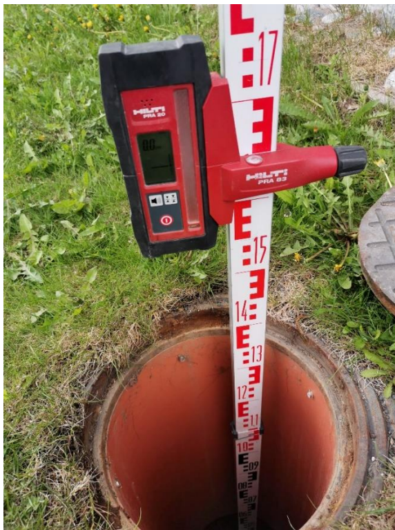
KUVA 8. Salaojaputken korko perusvesikaivossa (Niemi 2019-05-11)
