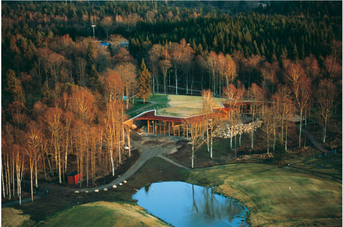
Kuva 14. Maastoon upotetun klubirakennuksen katolle on sijoitettu ensimmäisen väylän aloituslyöntipaikka. Kuva: Stefan Hallberg ( https://inhabitat.com/golfers-can-tee-off-from-wingardh-architects-green-roofed-clubhouse-in-sweden/a%C2%80jared-2/ )
