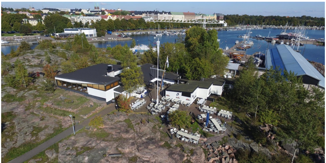
Kuva 22. Ravintola ja seuratilat on jaettu kahteen eri rakennukseen. Kuva: ( https://www.ravintolasaari.fi )
