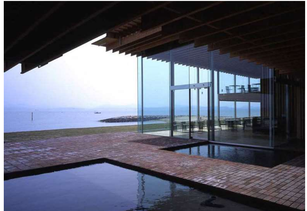
Kuva 34 Näkymä merelle avautuu hienosti sekä lasin läpi että täysin ilman esteitä. Näkyviin jätetty kattorakenne tuo rytmin lisäksi näkyviin hienoa kerroksellisuutta, sillä eri korkeisten massojen palkit ovat eri korkeuksilla. ( www.kkaa.co.jp/works/architecture/sea-fil-tert .)
