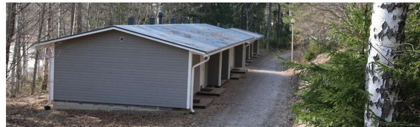
Kuva 10 Vanhan puolen majoitusrakennukset kuvattuna vanhan puolen päärakennuksen edustalta 5.4.2019 © Aki Sahrman.
