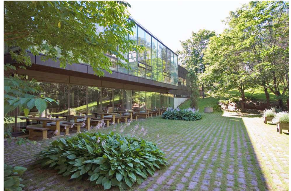
Kuva 39 Valokuva Murikan päärakennuksesta ulkoapäin (helinco.fi).
