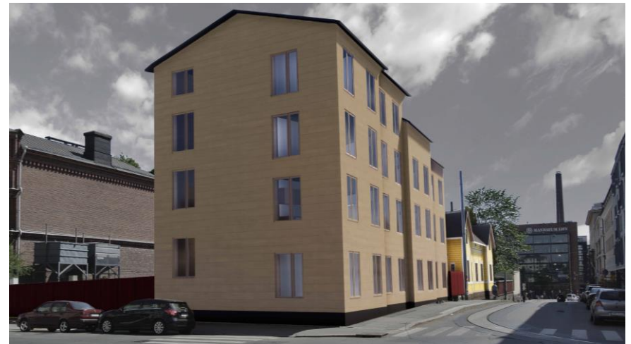
Kuva 52. Uudisrakennus Kalevankadun ja Hietalahden kadun kulmasta katsottuna
