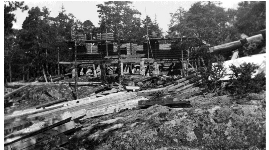
Kuva 3. Kuokkalasta siirrettyä hirsirakennusta kootaan uuteen sijaintiinsa Villingissä [HKM, 1924, tuntematon]
