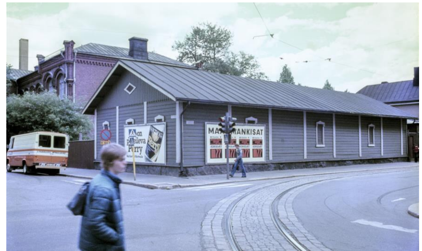
Kuva 21. Kuva vajasta Kalevankadun ja Hietalahdenkadun kulmasta vuodelta 1977 [Punkari, Pekka, 1977, HKM]
