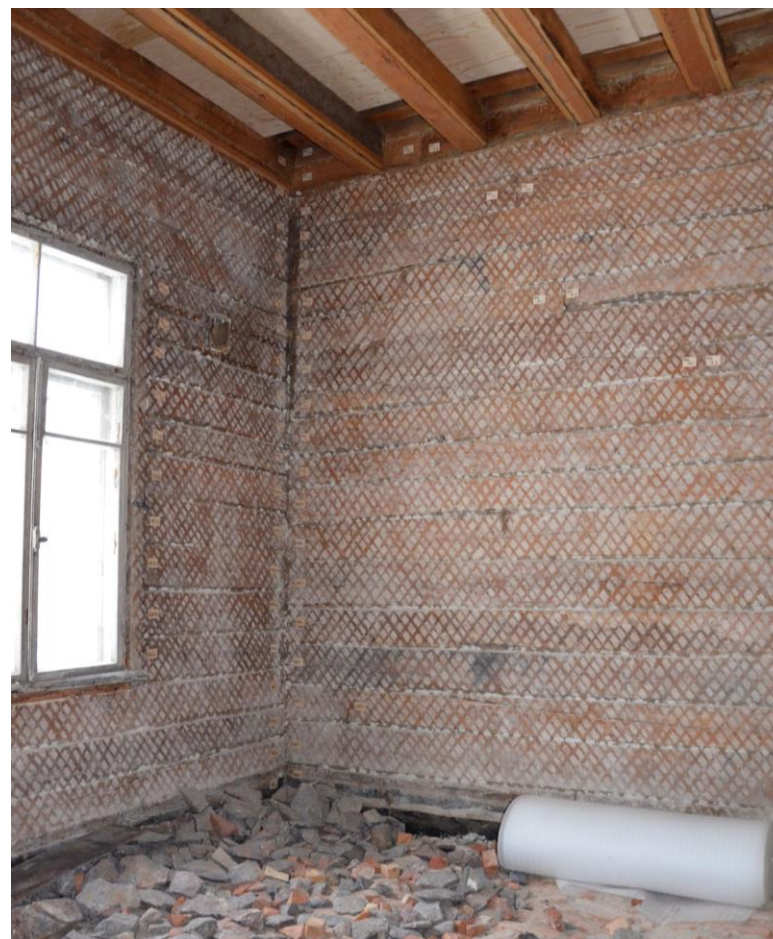
Kuva 27. Eristysrakennuksen sisätila, lattialla vielä purkujätettä
