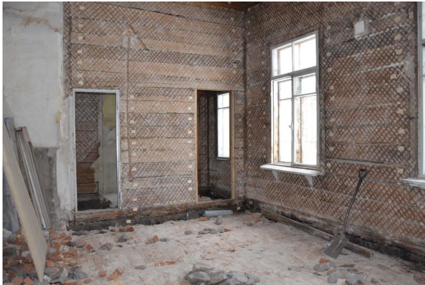
Kuva 30. Rakennuksen sisäpinnat on purettu, joten rakenteita pystyy arvioimaan silmämääräisesti paremmin
