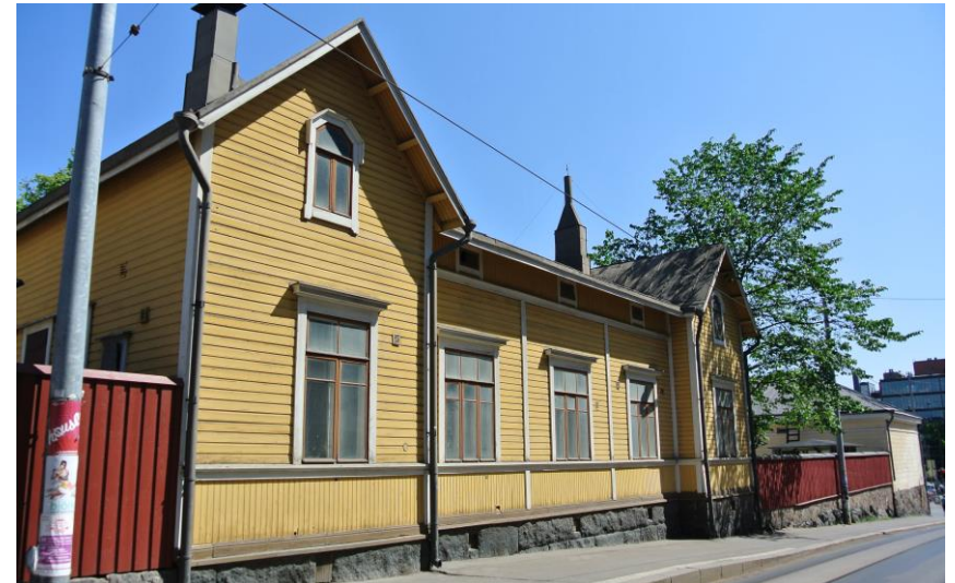
Kuva 17. Eristysrakennus Hietalahdenkadulta kuvattuna
