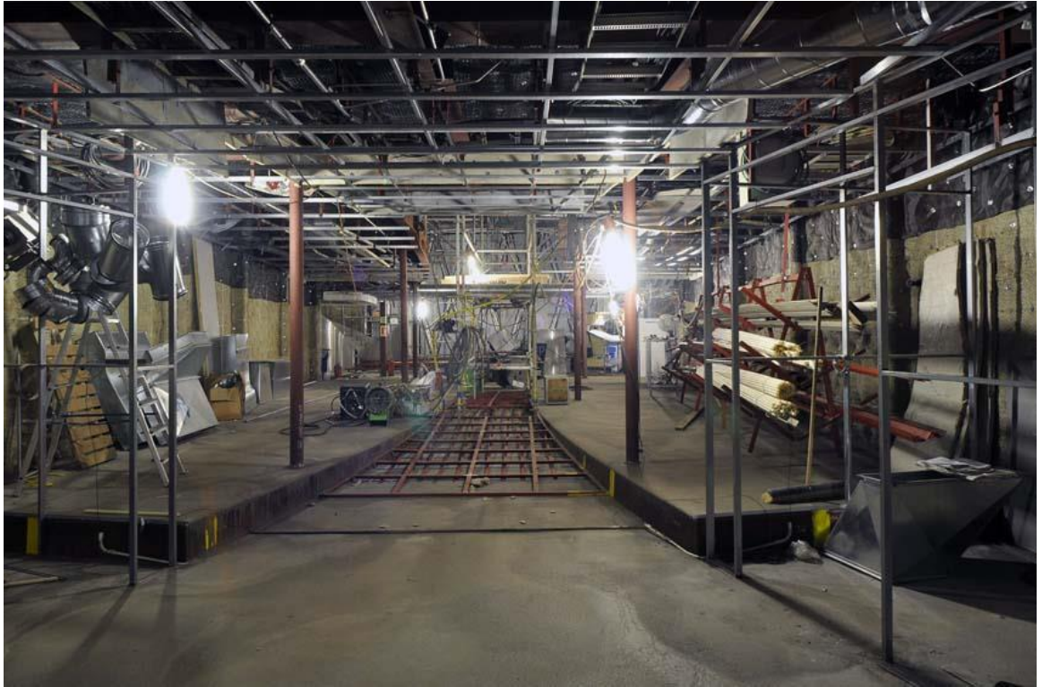
Kuva 10. Seinien ja kattojen koolausrakenteita rakenteilla olevassa laivassa (Elomatic 2019).
