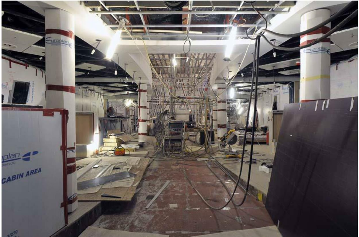
Kuva 11. Seinävuoraukset asennettuna ja suojattuna, osa kattovuorauksesta asennettuna (Elomatic 2019).
