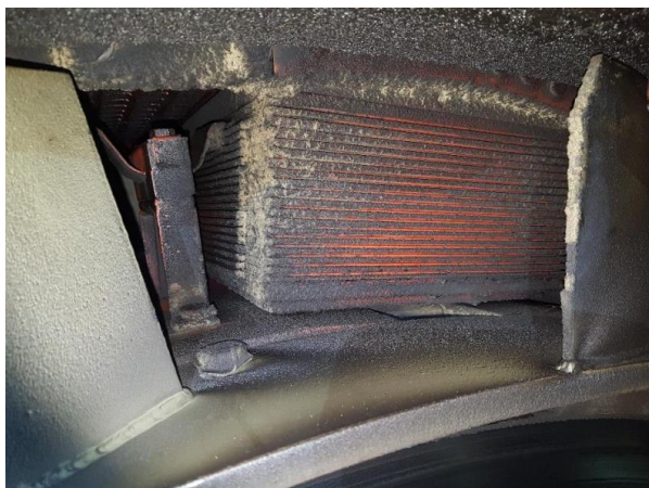
Figur 10. Koldamm vid rotorns poler. (Kivelä & Piekkola, 2018)
