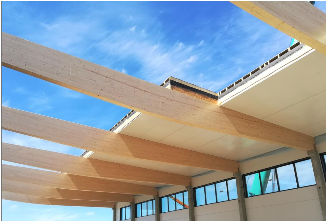
Kuva 2. Kattoelementtien asennus. /1/.
