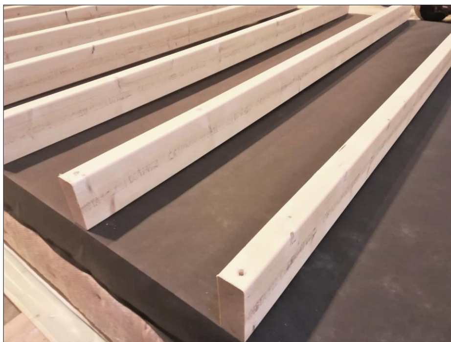
Kuva 7. Tuulensuojakangas, kattovasat ja tuuletustila. /1/.
