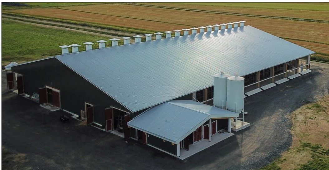
Kuva 11. Kohteessa kattoelementit toimitettu ruode ja aluskate valmiina. Paikalla asennettu peltikatto. /1/.
