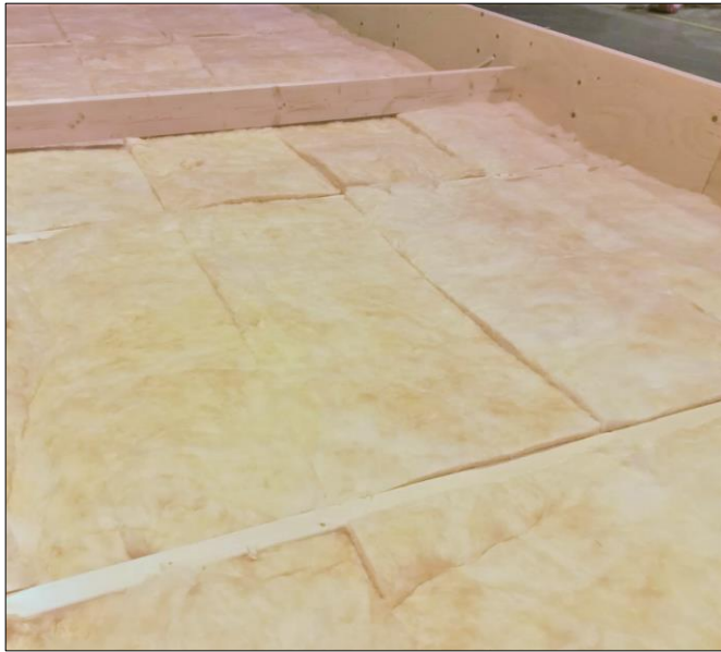
Kuva 6. Mineraalivillakerros (B-s1,do) kattoelementissä. /1/.
