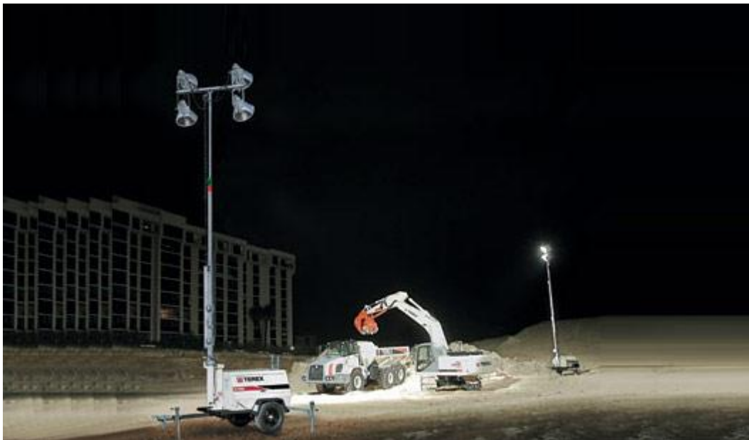
KUVA 12. Konetyöpiste, joka on valaistu kahdesta suunnasta liikuteltavilla suuritehoisilla valomastoilla (LightTowerparts)
