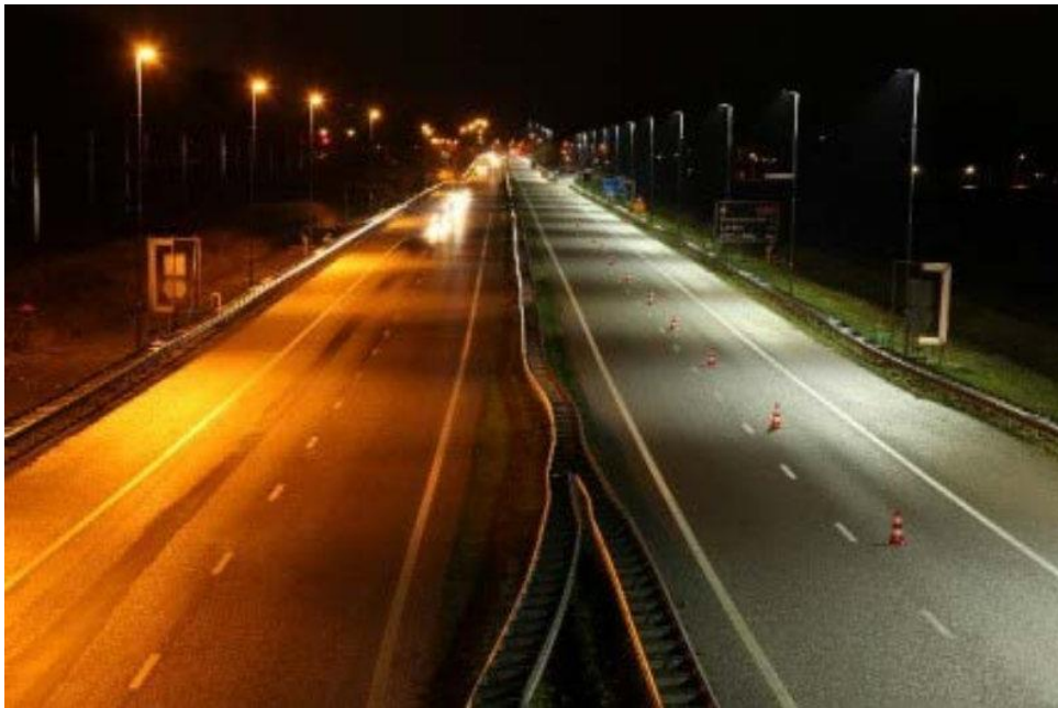
KUVA 2. Ero pienpainenatriumlampulla ja led-valaisimella valaistujen moottoritiekais- tojen välillä (on-light.de)
