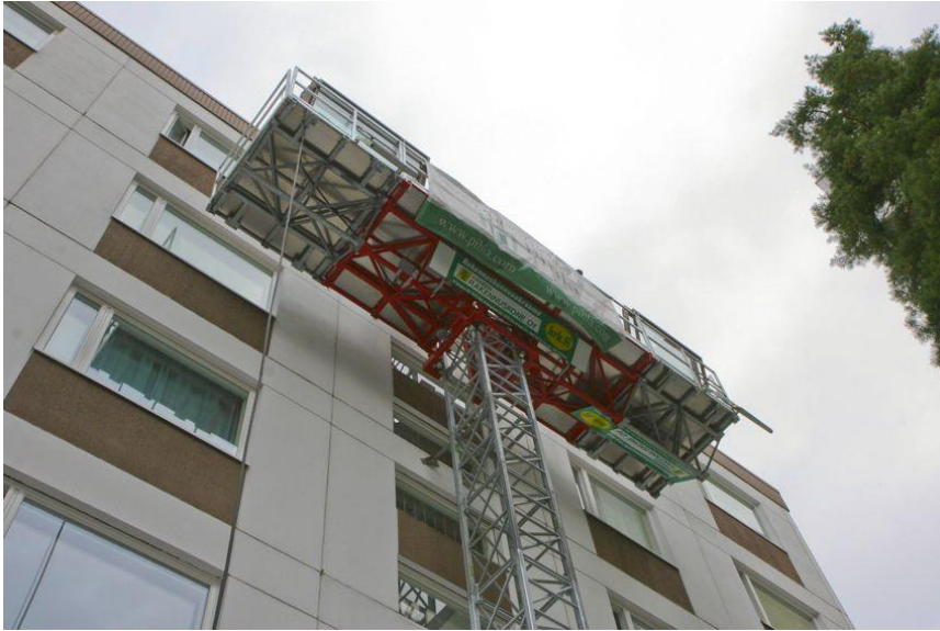
KUVA 13. Mastolava Scanclimber SC4000 julkisivutöissä (HRK konevuokraamot)
