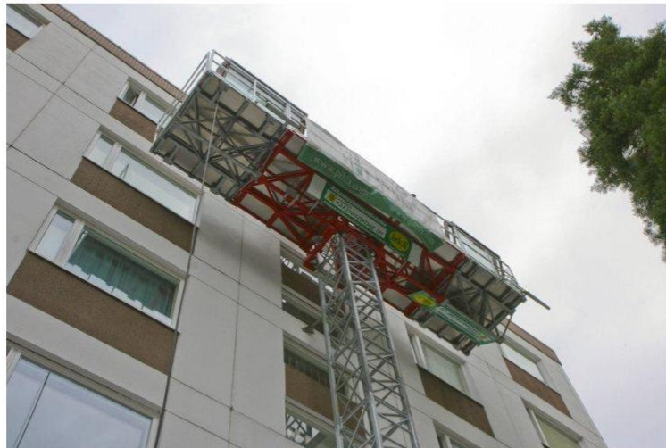
Mastolava Scancelimber SC4000 julkisivutöissä (Kuva: HRK konevuokraamot (21) )
