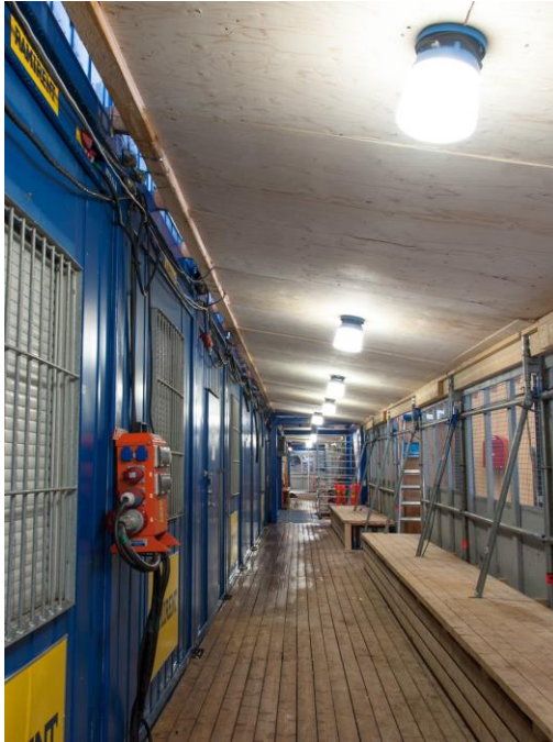
KUVA 10. Ympärisäteilevillä led-työmaavalaisimilla valaistu katettu kulkutie työmaan sosiaalitilojen yhteydessä (STT Info)
