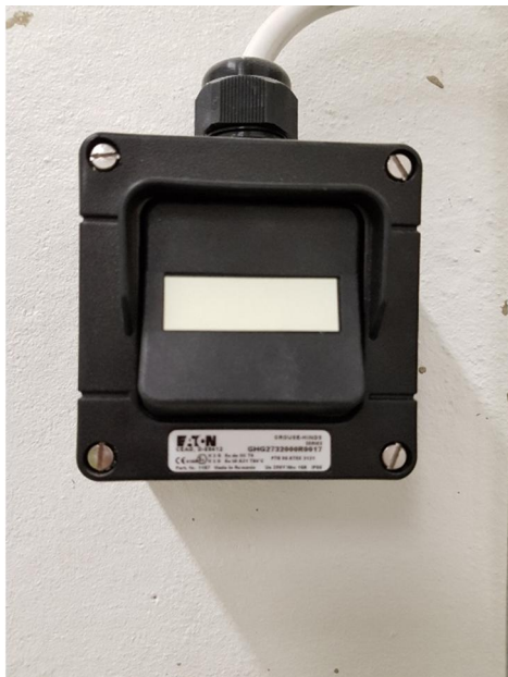
Kuva 5. ATEX-tilaan asennettava kytkin on kooltaan normaalia suurempi
