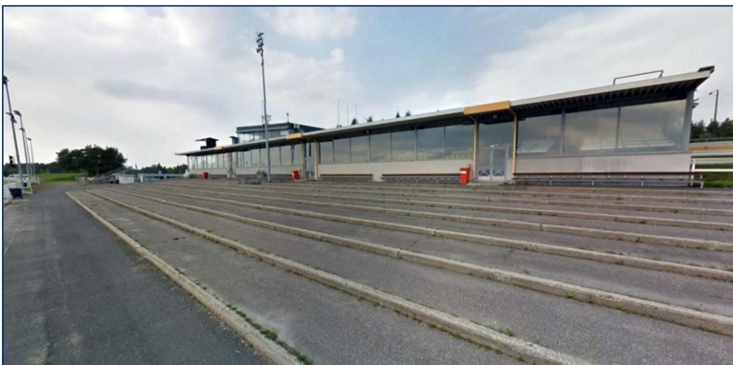
KUVA 20. Äimäraution katsomorakennus vuonna 2011 (Google Maps. 2019)
