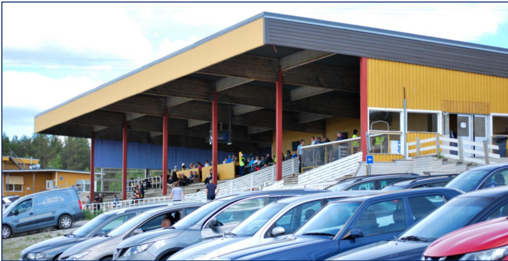
KUVA 7. Autokatsomo ja taustalla Kajaanin raviradan katsomorakennus
